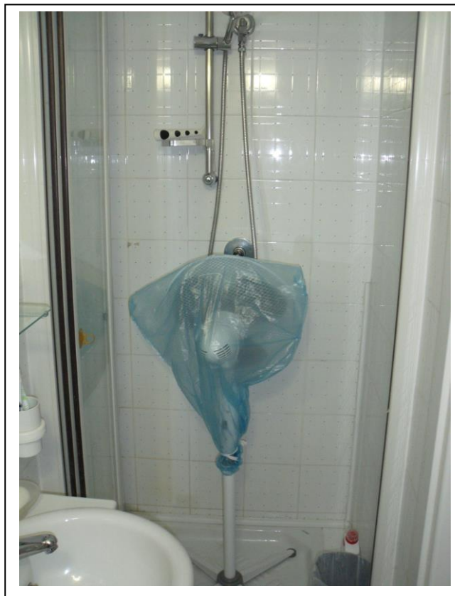
26. Interno dell'unità immobiliare con vista piccolo servizio igienico, ricavato nel sottoscala. Esposizione verso lato nord-est.
