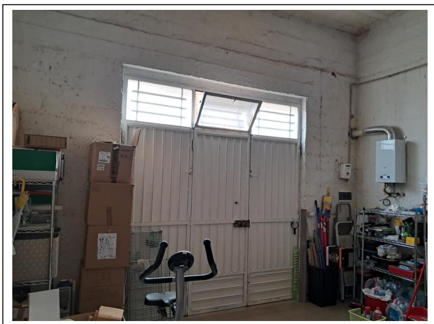
28. Interno dell'unità immobiliare sub. 15 al p.t. con vista su ante di accesso metalliche dal lato strada. Esposizione verso lato est.
