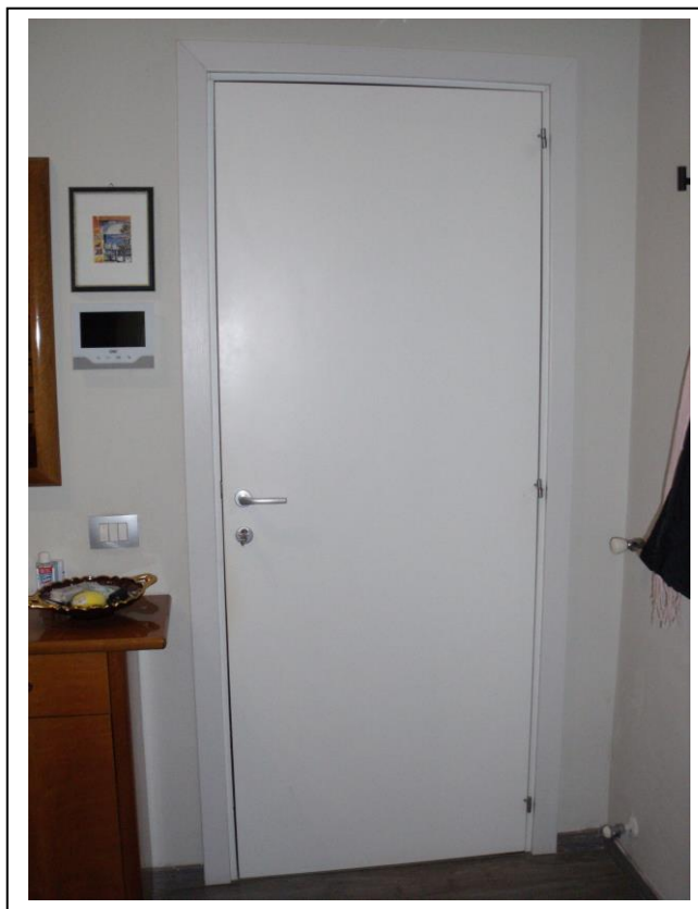
09. Interno u. i. sub. 16 con vista verso lato porta d'ingresso. Vista foto verso lato sud-ovest.
