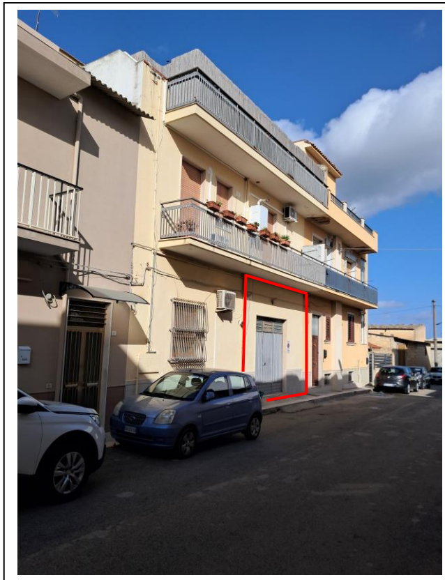
03. Prospetto principale dell'unità immobiliare sub. 15 su via Ugo La Malfa, vista prospettica. Accesso diretto dal lato strada, presenza di marciapiede. Esposizione lato SE.
