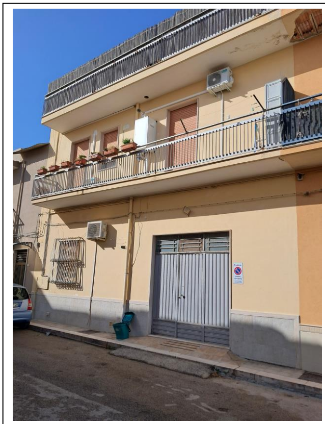
04. Prospetto principale dell'unità immobiliare sub. 15 su via Ugo La Malfa, vista prospettica. Accesso diretto dal lato strada, presenza di marciapiede. Esposizione lato SE.
