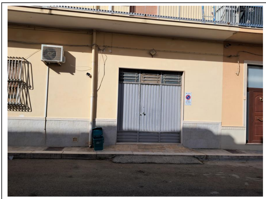
27. Prospetto principale dell'unità immobiliare sub. 15 su via Ugo La Malfa, vista prospettica. Accesso diretto dal lato strada, presenza di marciapiede. Esposizione lato SE.
