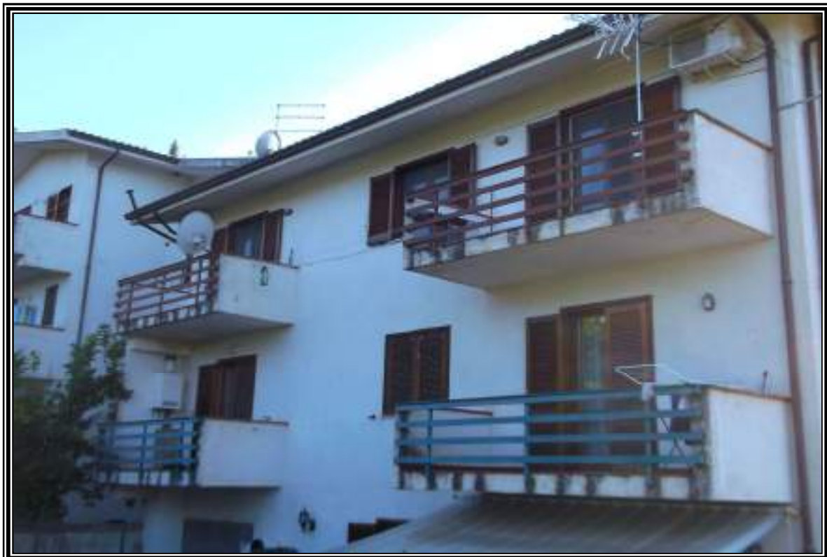
FOTOGRAFIA n. 2 - Vista Esterna Posteriore -
