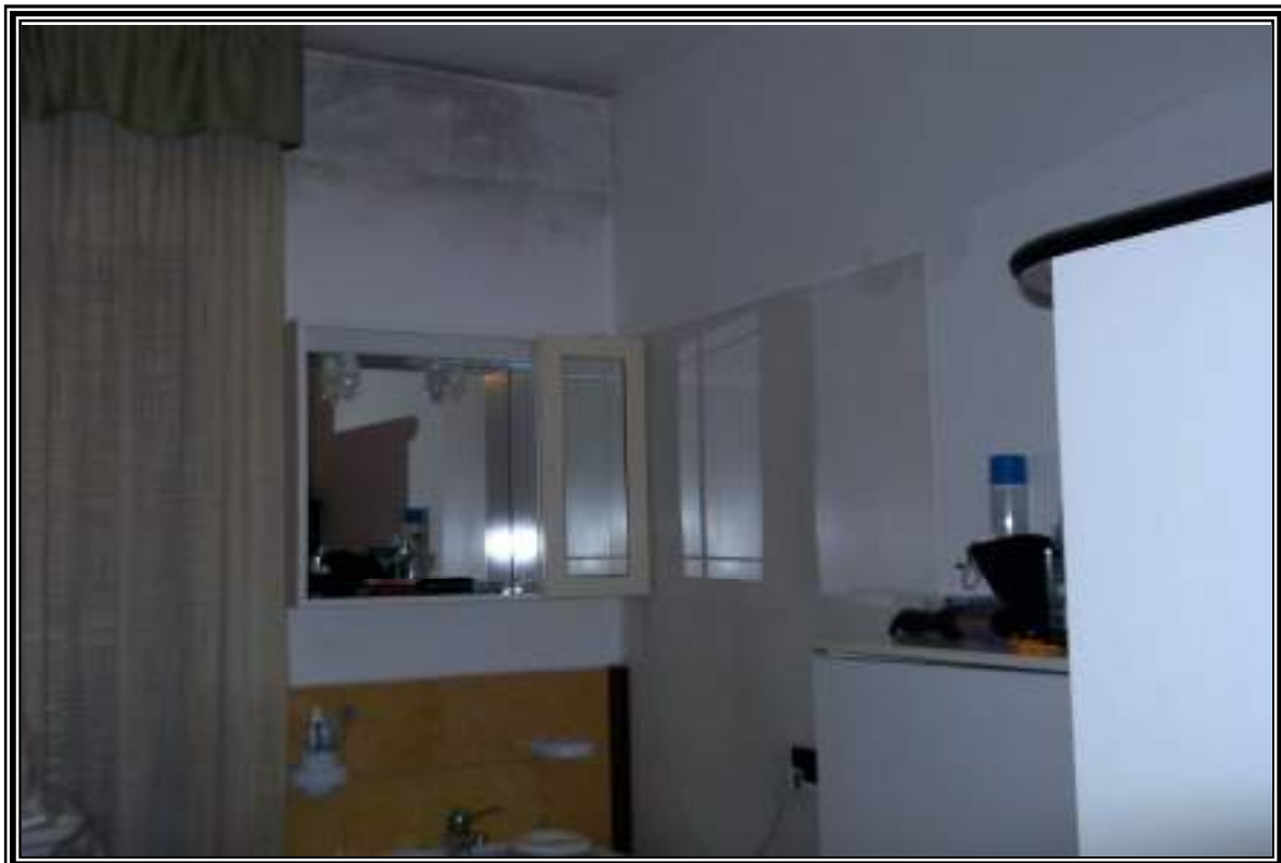
FOTOGRAFIA n. 6 – “Unità 1” (Piano Terra) -
