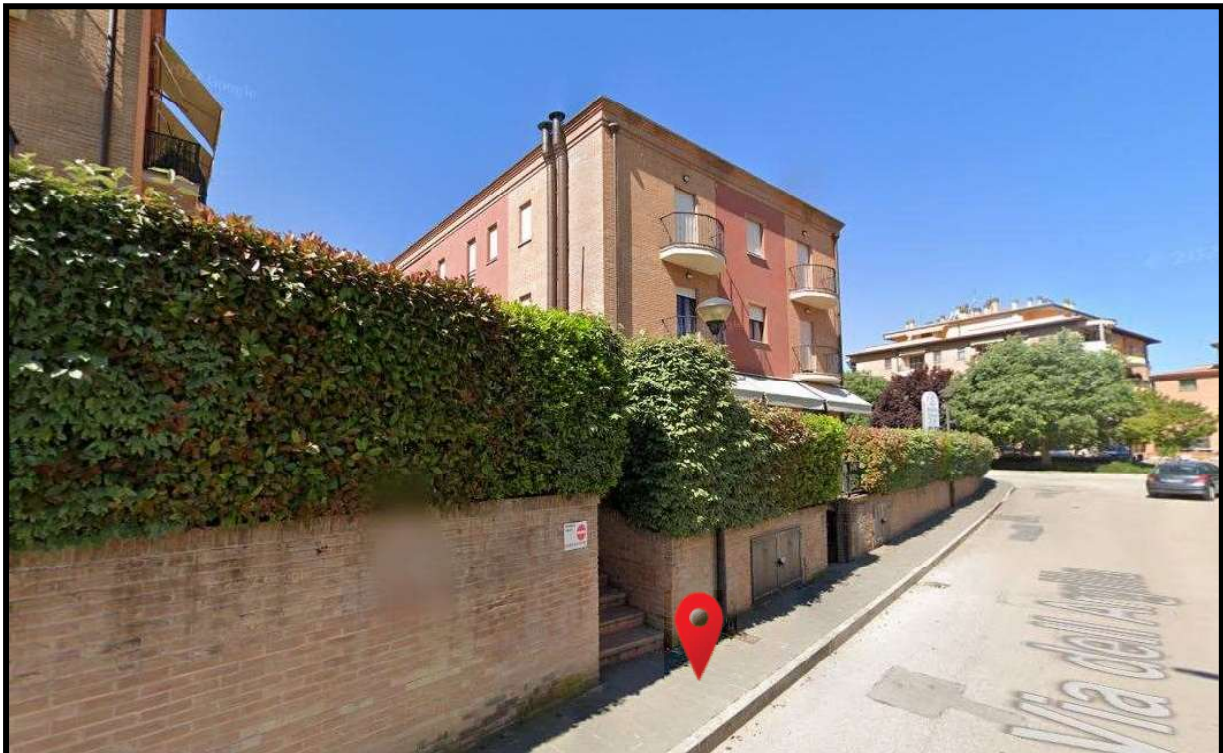
2 – vista da via dell'Argilla, con accesso al numero civico 2
