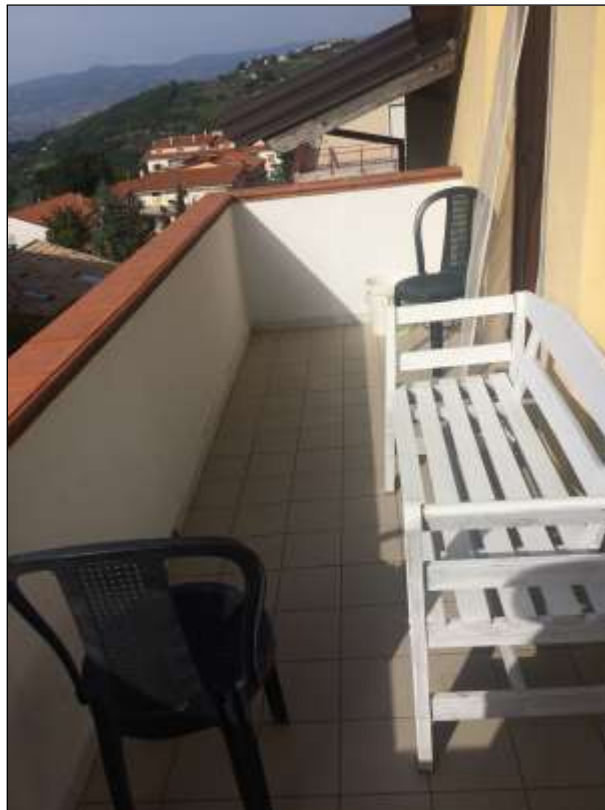
Foto n. 16: Esterno dell'immobile Balcone Lato Cucina
