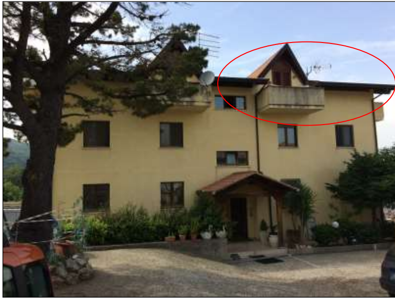
Foto n. 1: Esterno dell'immobile Prospetto Principale
