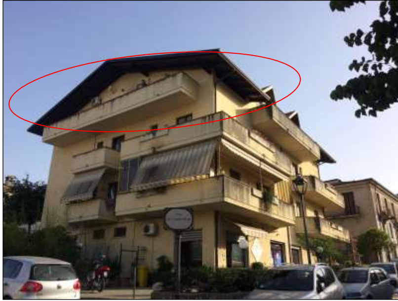
Foto n. 15: Esterno dell'immobile Prospetto Lato Strada
