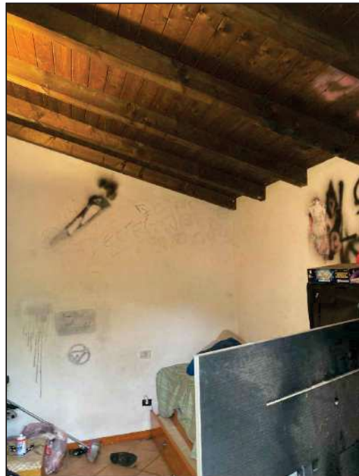
Foto 24 - CAMERA, DETTAGLIO SOFFITTO
