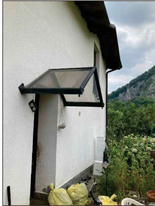
Foto 05 - FACCIATA SUD, INGRESSO
