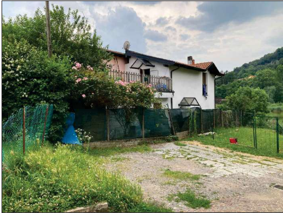
Foto 11 - VISTA IMMOBILE DA SUD-OVEST
