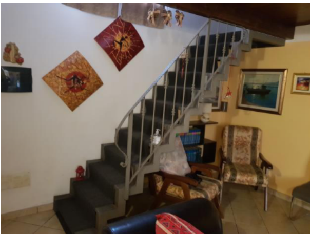
Scala in ferro collegamento al piano soppalco
