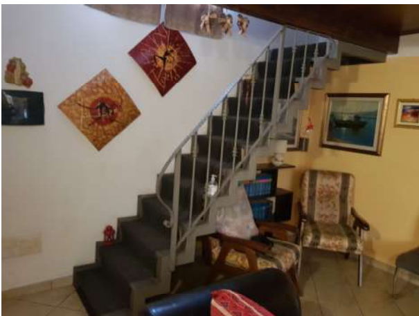
Scala in ferro collegamento al piano soppalco
