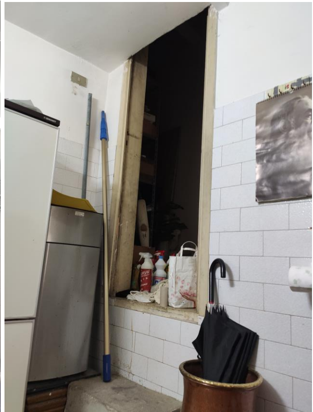
Piano terra: Servizio Igienico [Foto 10]
