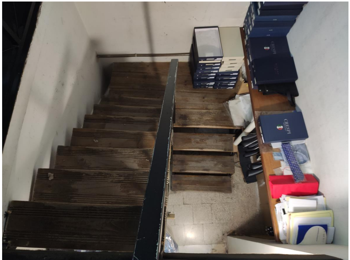
Scala in ferro con pedate in legno [Foto 13]
