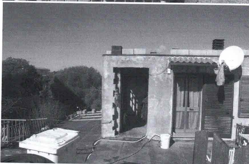
piano 1- accesso al sub 3 e 4
