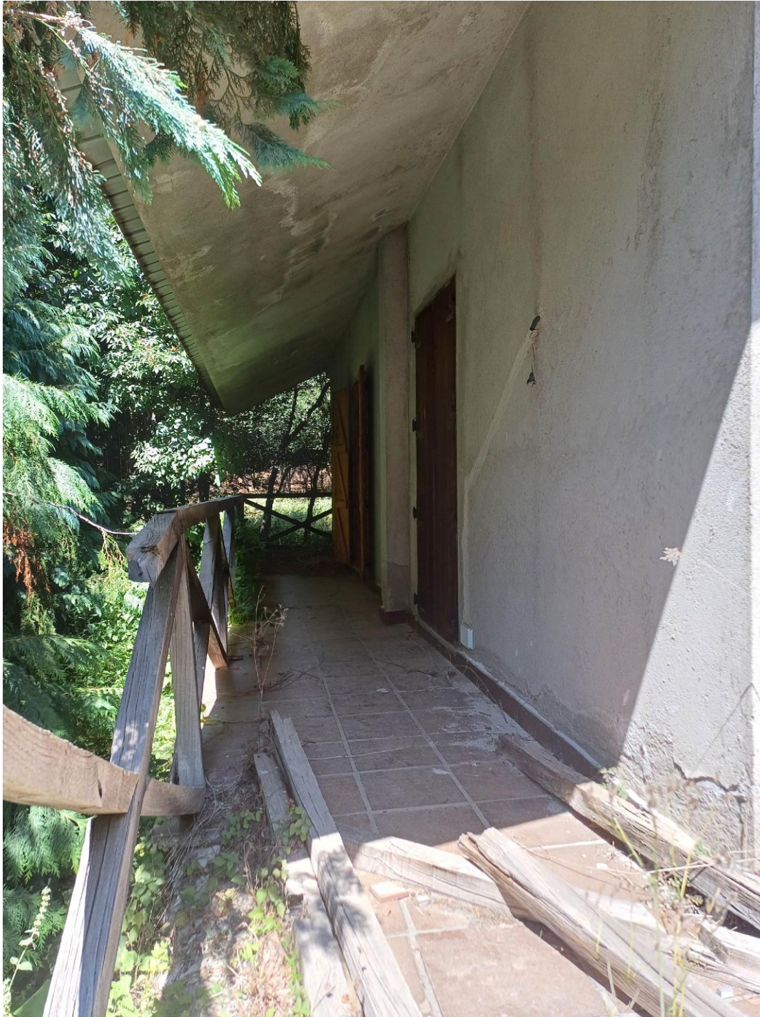
Foto N.4: Prospetto fabbricato Ovest.
