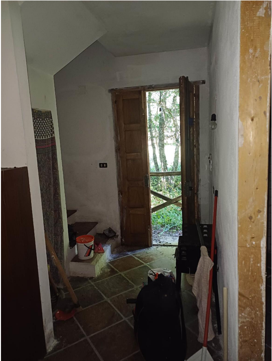
Foto N.5: Ingresso,disimpegno e corpo scala.
