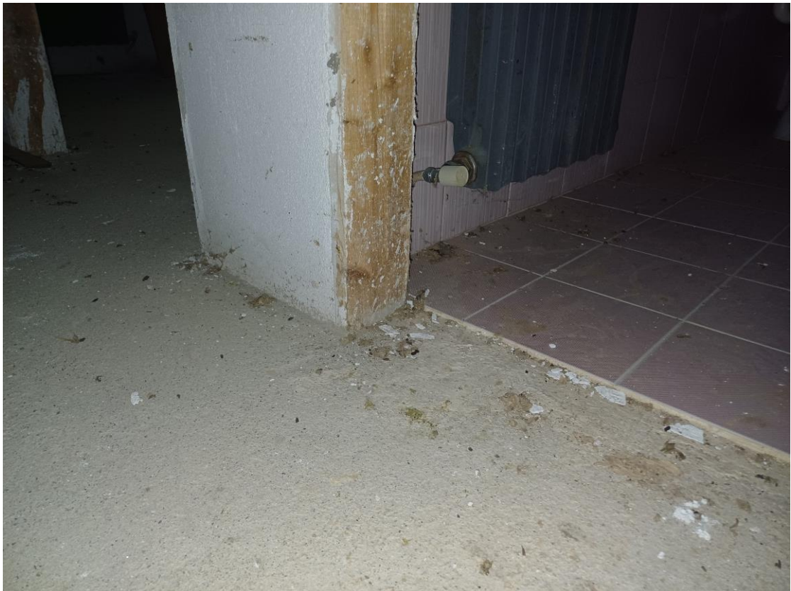
Foto N.23: Particolare pavimentazione Bagno 3 e disimpegno.
