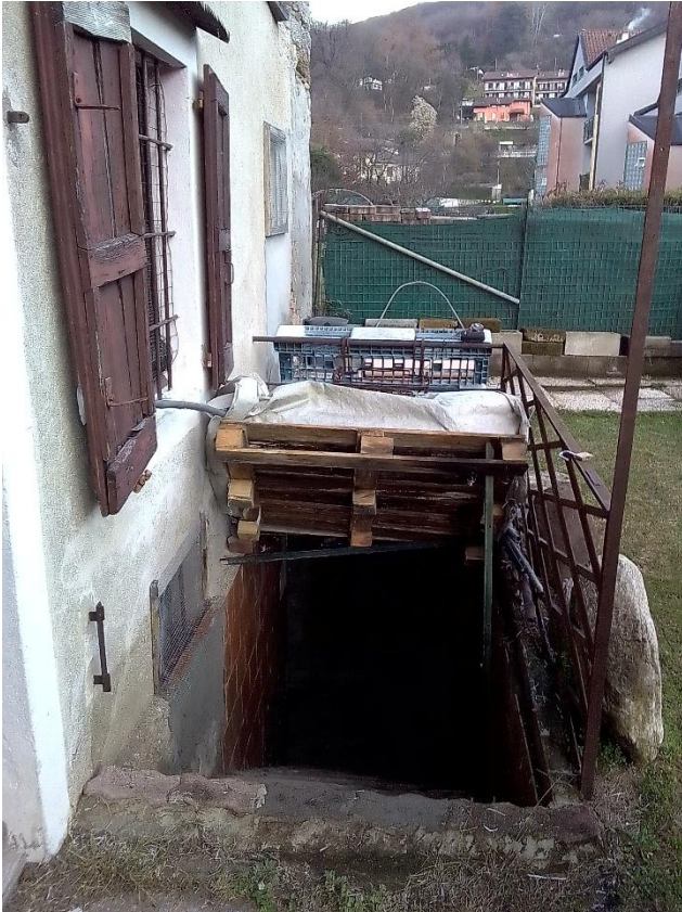
FOTO 4 – ACCESSO A CANTINA INTERRATA
