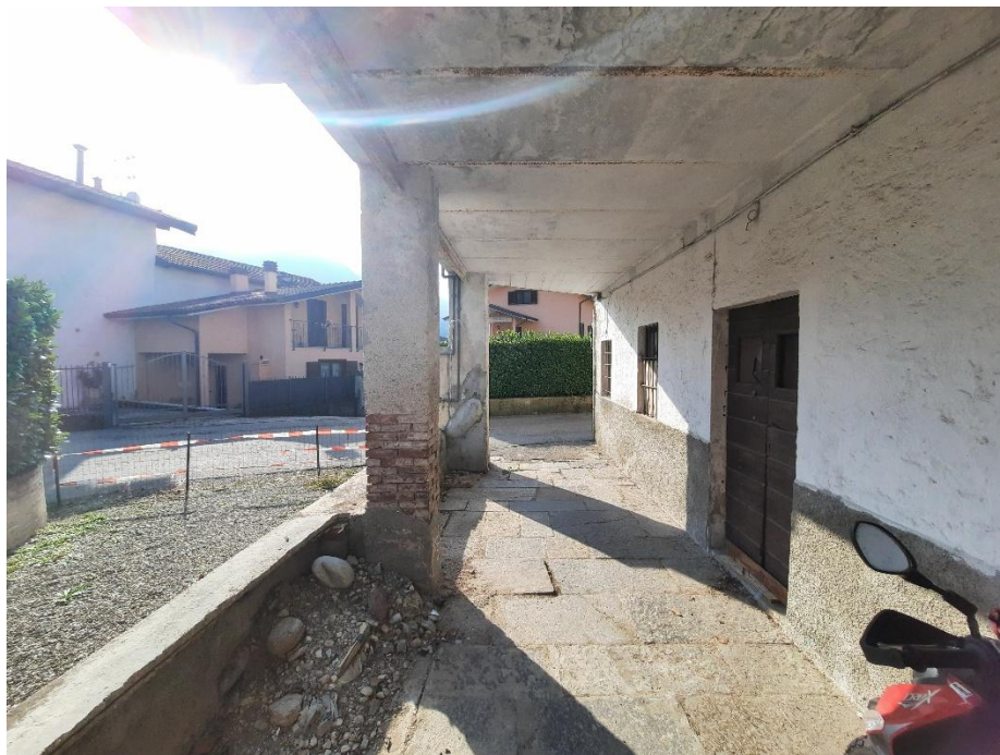
FOTO 4 – VISTA PORTICO PIANO TERRA
