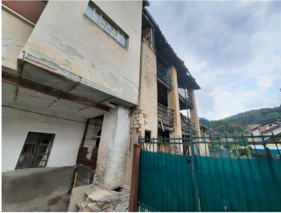
FOTO 5 – VISTA DAL CORTILE INTERNO
