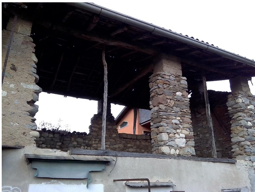
FOTO 3 – VISTA DALL'ESTERNO PIANO PRIMO LEGNAIA
