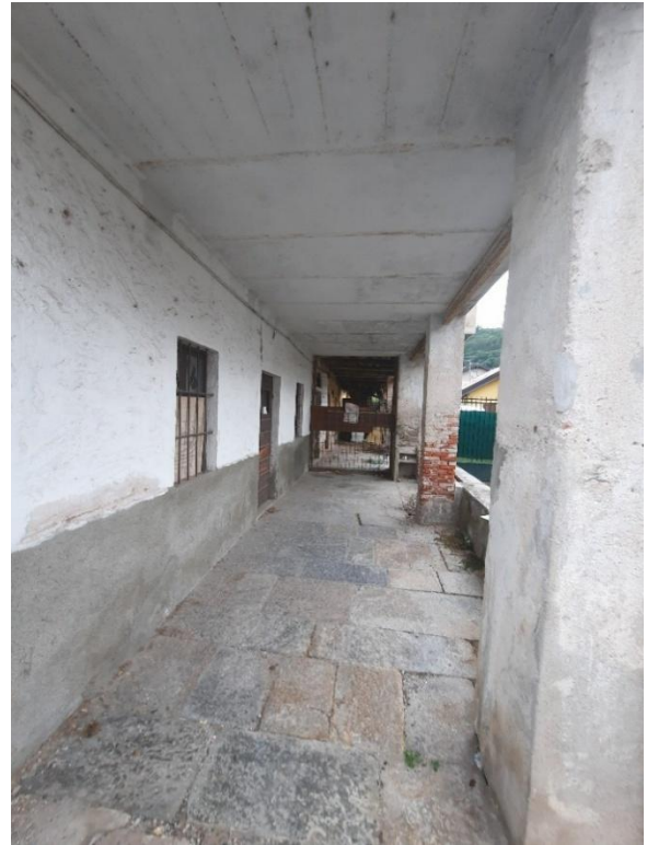
FOTO 3 – VISTA PORTICO PIANO TERRA
