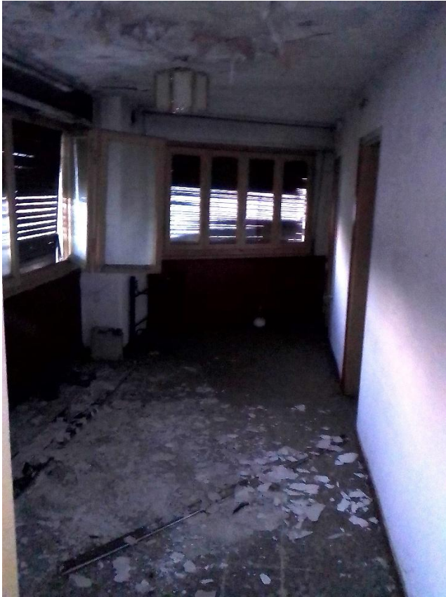
FOTO 12 – LOCALI INTERNI PIANO PRIMO
