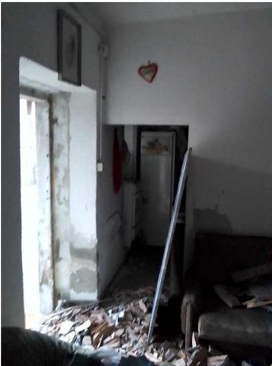
FOTO 32 – INGRESSO PIANO TERRA
