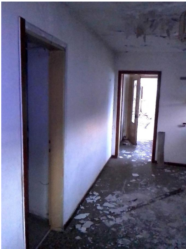
FOTO 14 – LOCALI INTERNI PIANO PRIMO
