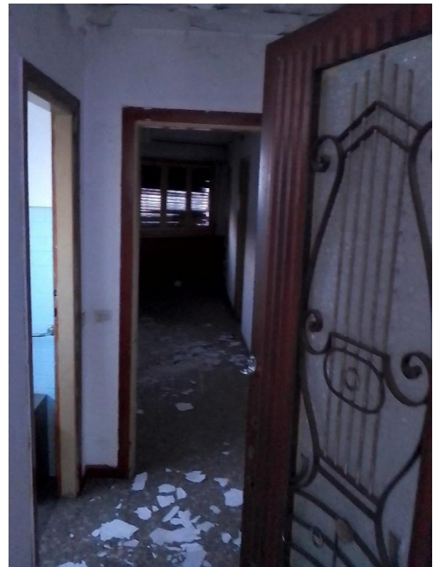
FOTO 15 – LOCALI INTERNI PIANO PRIMO
