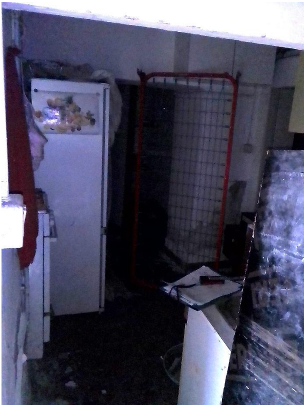
FOTO 19 – LOCALI INTERNI PIANO PRIMO
