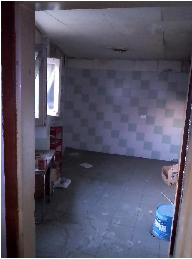
FOTO 16 – LOCALI INTERNI PIANO PRIMO
