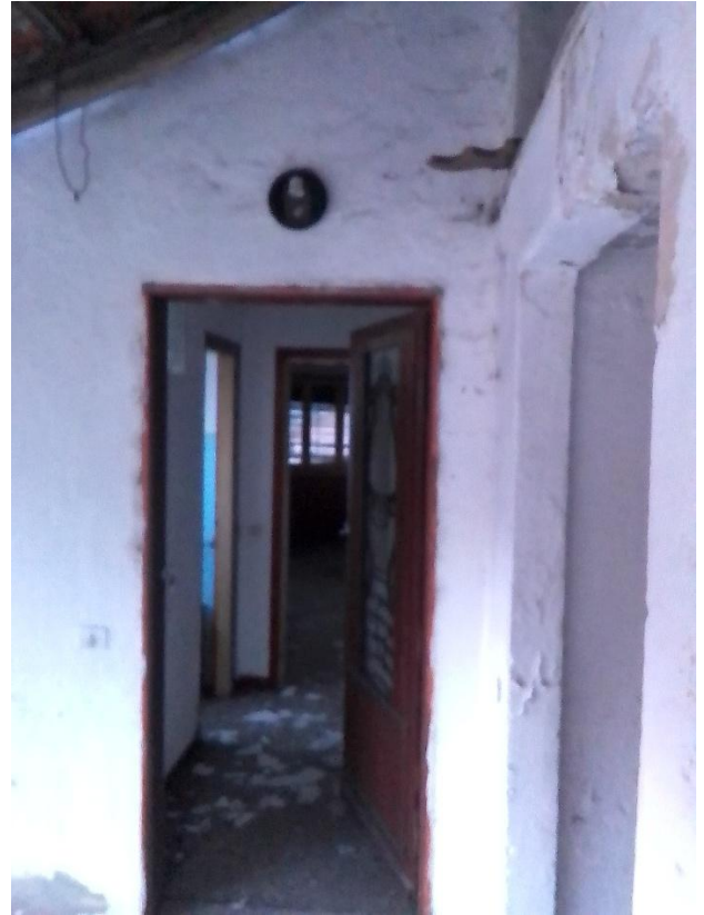
FOTO 27 – INGRESSO PIANO TERRA
