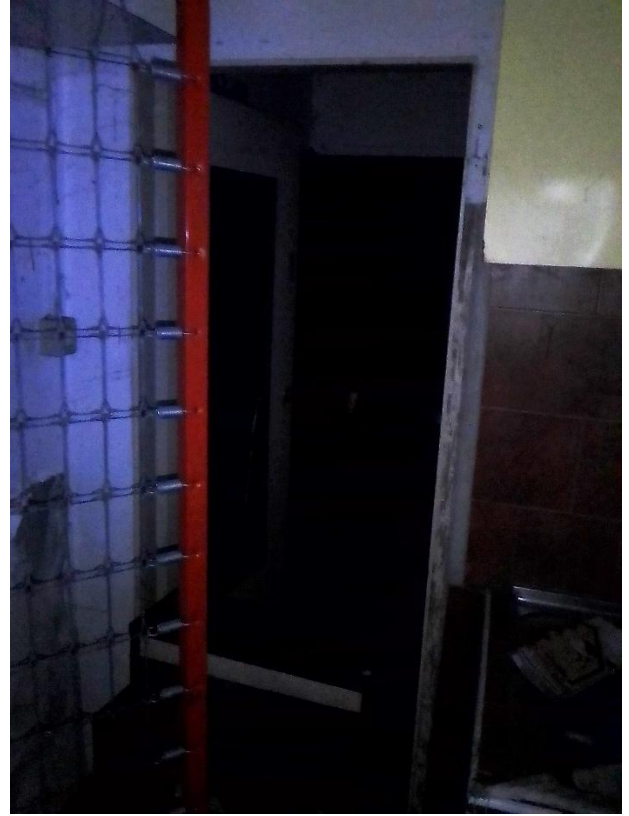
FOTO 21 – LOCALI INTERNI PIANO TERRA
