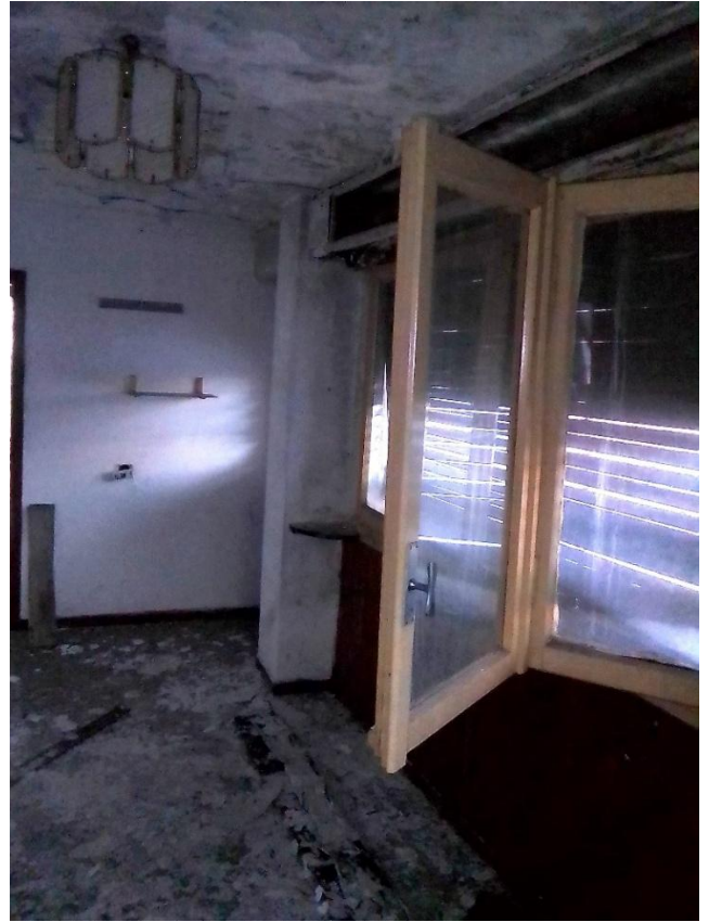
FOTO 13 – LOCALI INTERNI PIANO PRIMO
