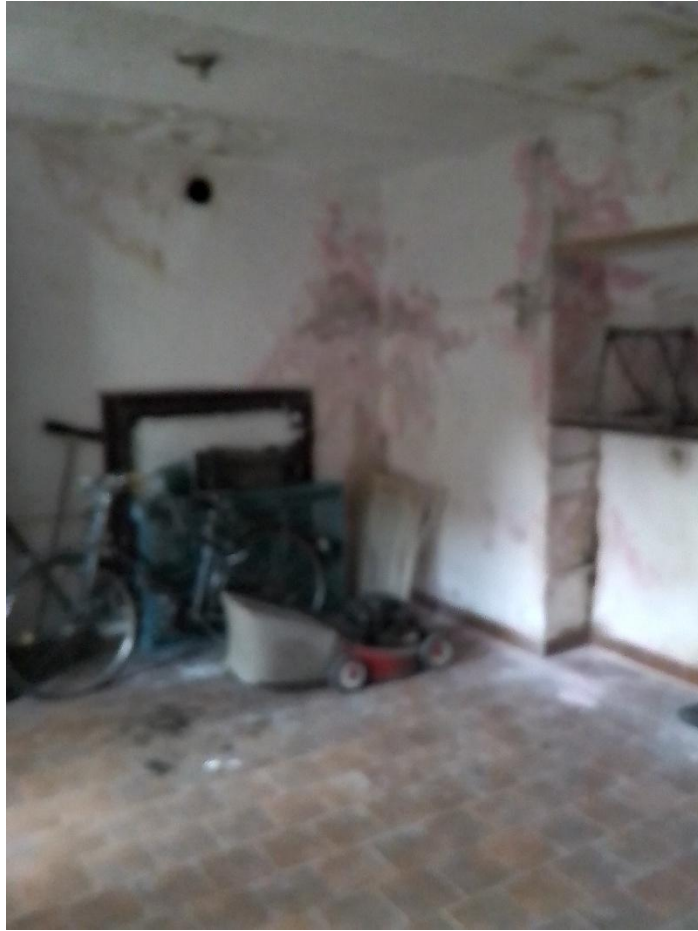
FOTO 11 – LOCALE SGOMBERO PIANO TERRA
