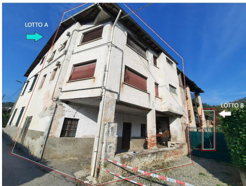
FOTO 1 – VISTA DELL'IMMOBILE DALLA STRADA
