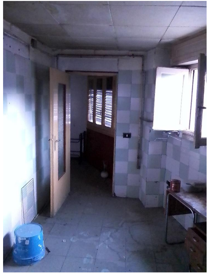
FOTO 17 – LOCALI INTERNI PIANO PRIMO
