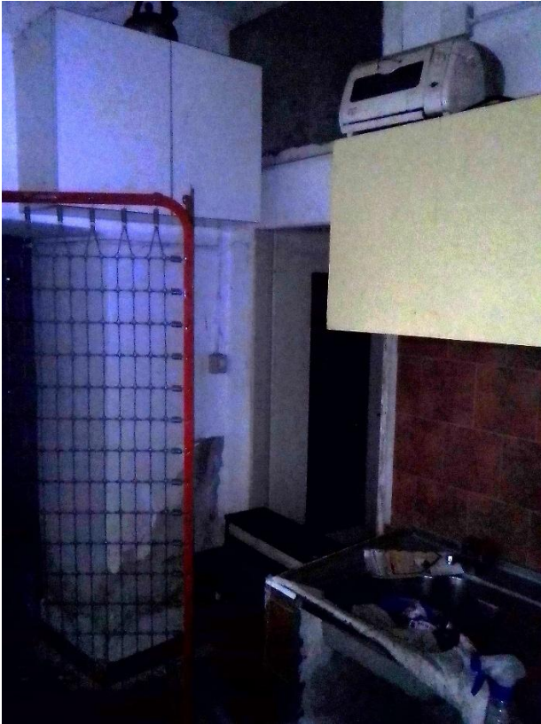
FOTO 20 – LOCALI INTERNI PIANO TERRA
