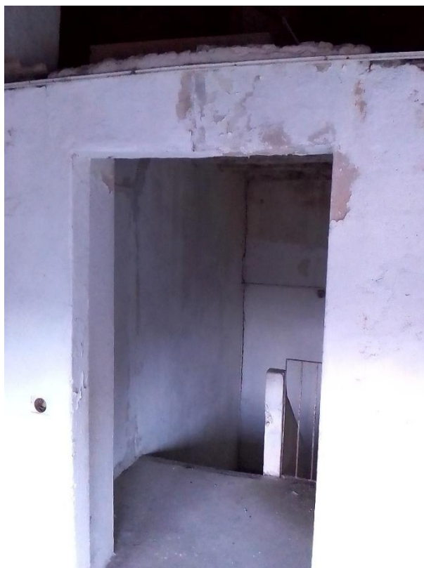
FOTO 25 – INGRESSO PIANO TERRA
