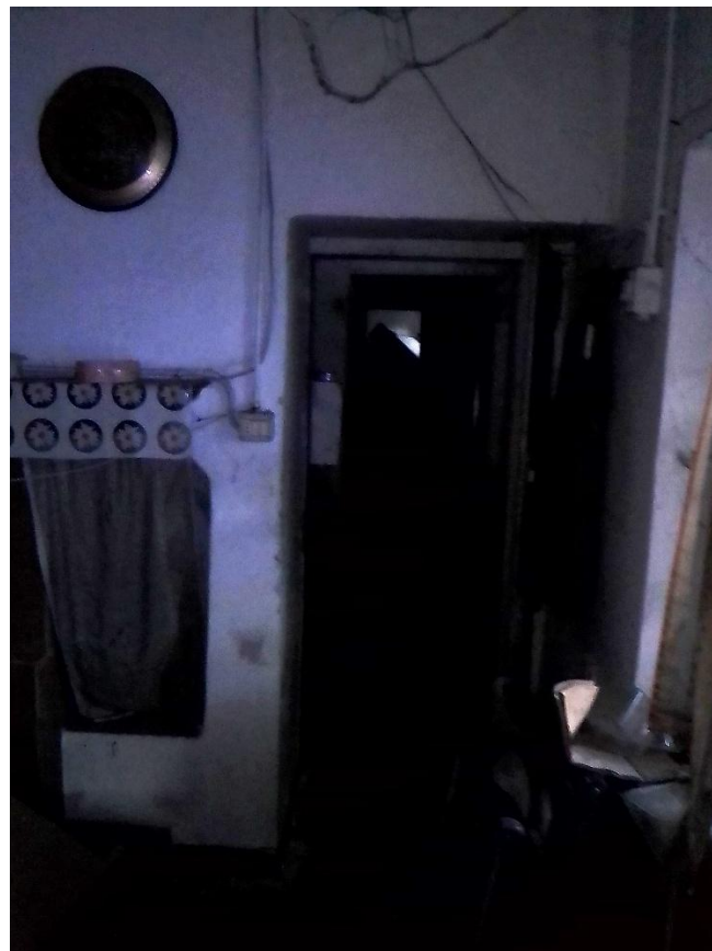
FOTO 22 – LOCALI INTERNI PIANO TERRA
