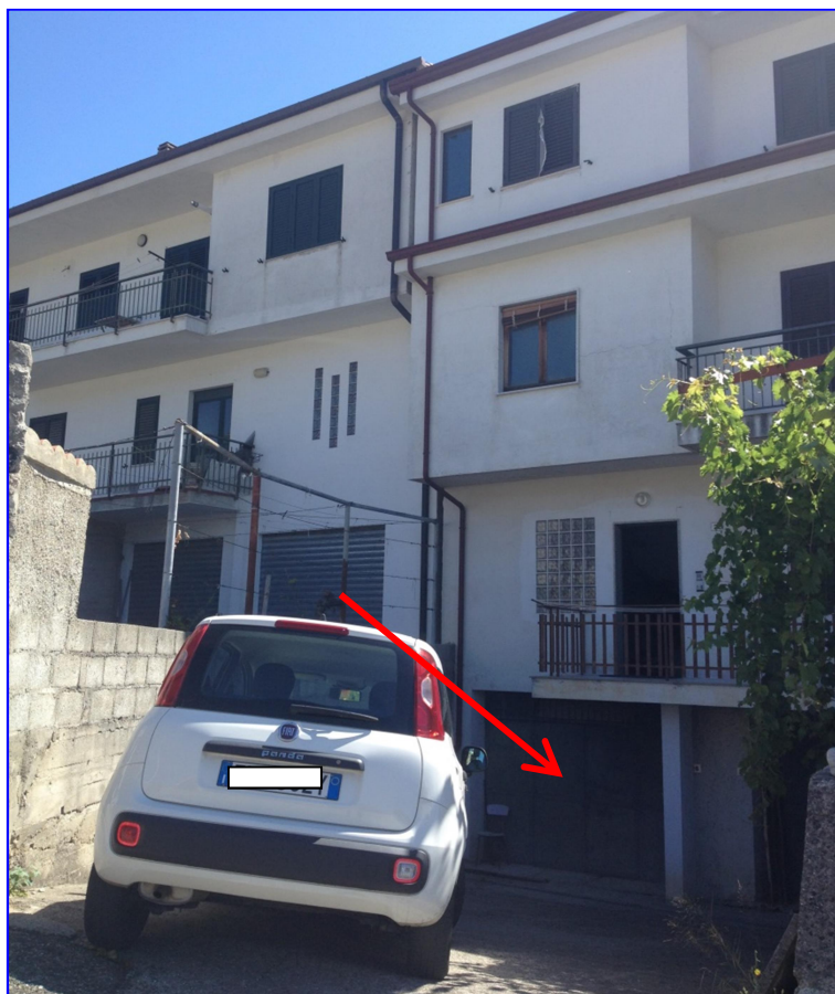
Foto 1 – Vista rampa di accesso e porta d'ingresso
