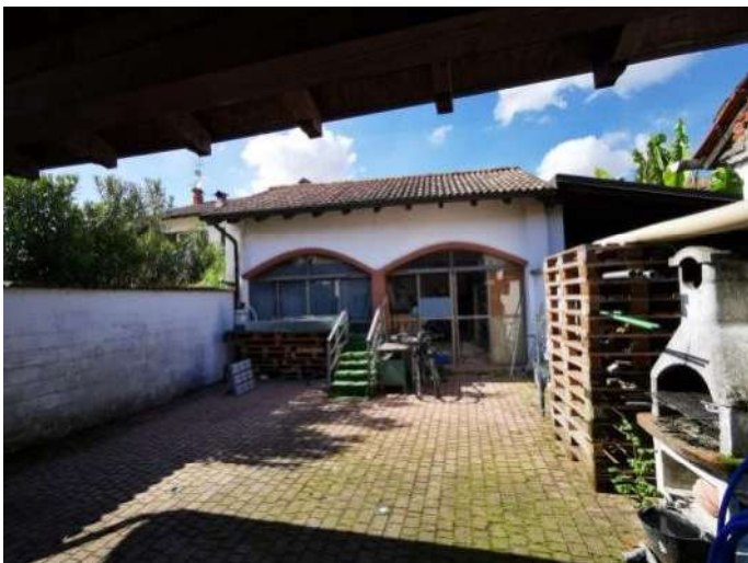
Locale di sgombero fronte sud - corte pertinenziale
