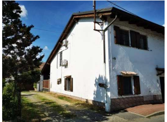
Fronte ovest e viabilità privata
