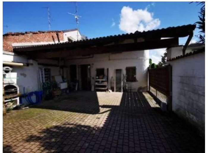
Fronte nord - portico
