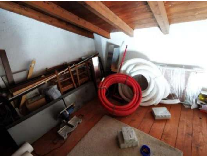
Edificio accessorio - locale di sgombero, soppalco
