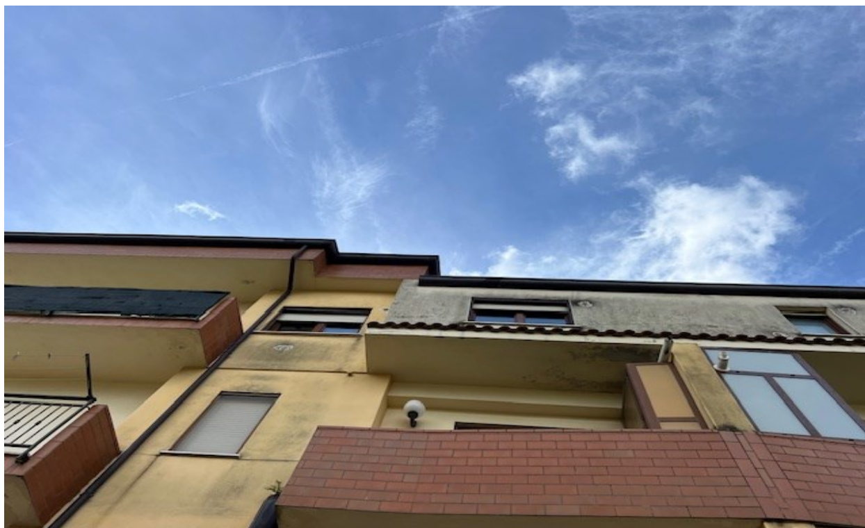
VISTA ESTERNA DEL FABBRICATO FG. 5 P.LLA 1441 NEL COMUNE DI AIROLA (BN)
