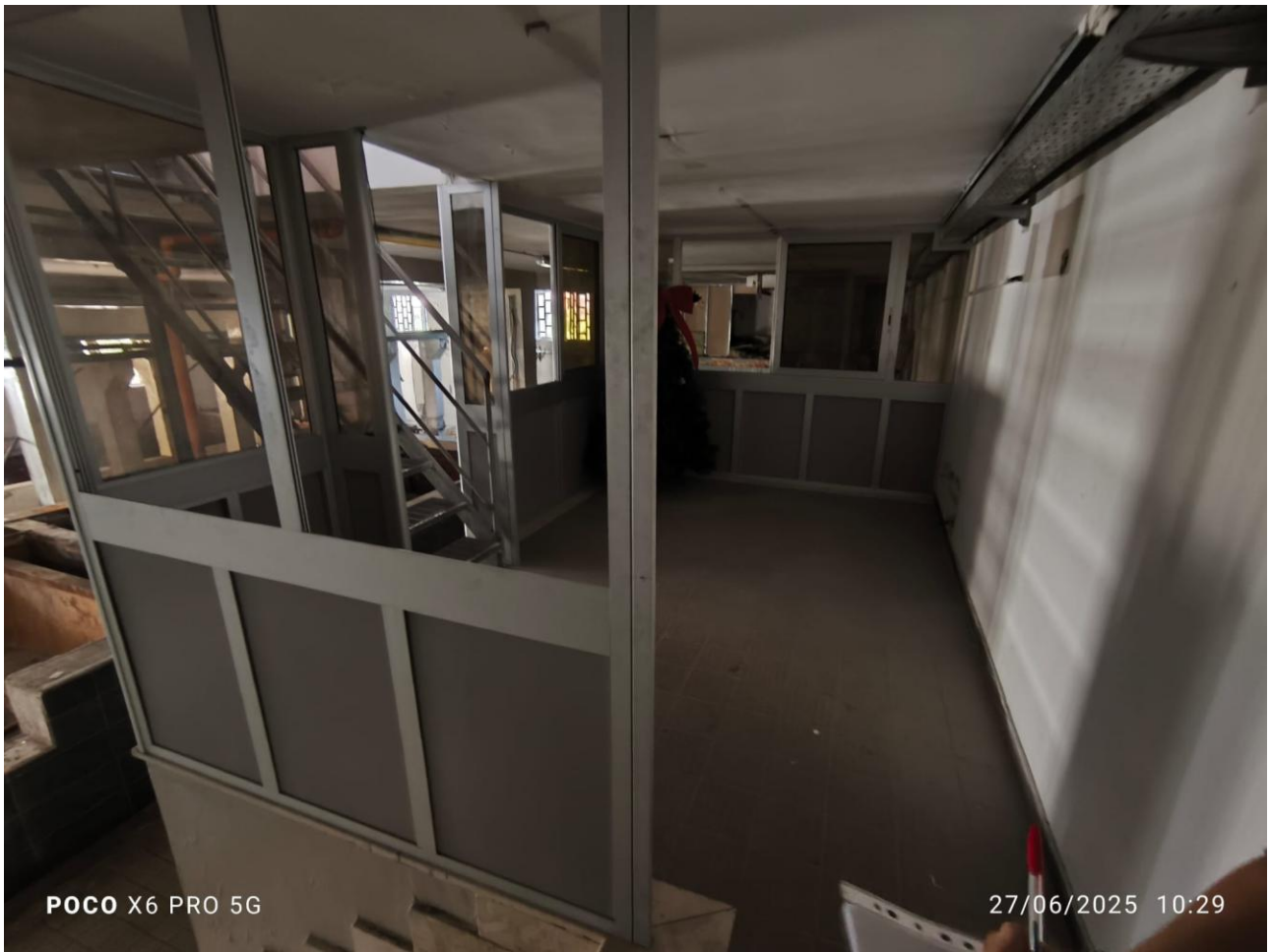
FOTO N. 12: Capannone Via Matilde Serao n. 21, “navata destra”, estradosso blocco bagni.
