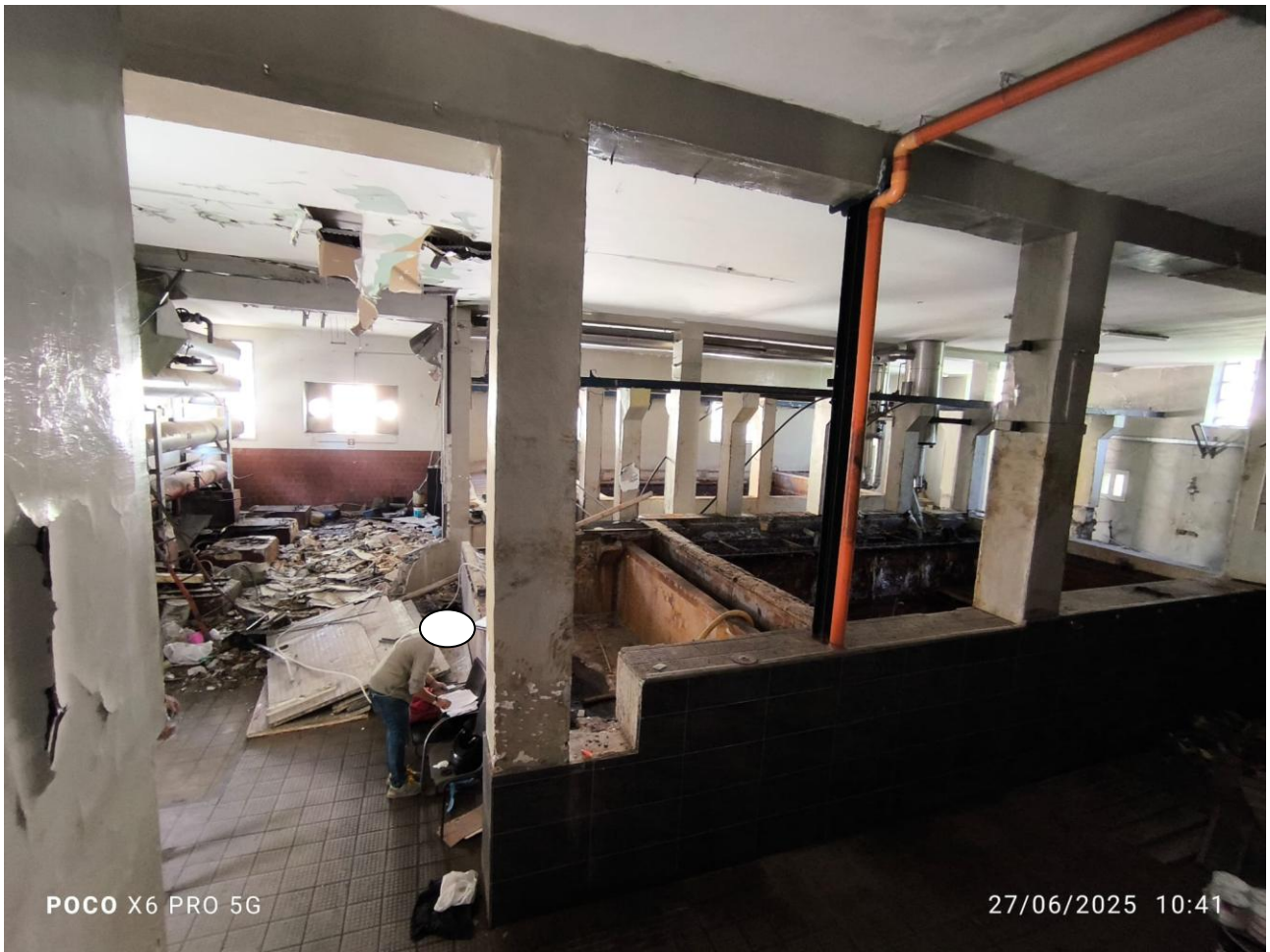
FOTO N. 21: Capannone Via Matilde Serao n. 21, vista interna dall'alto.
