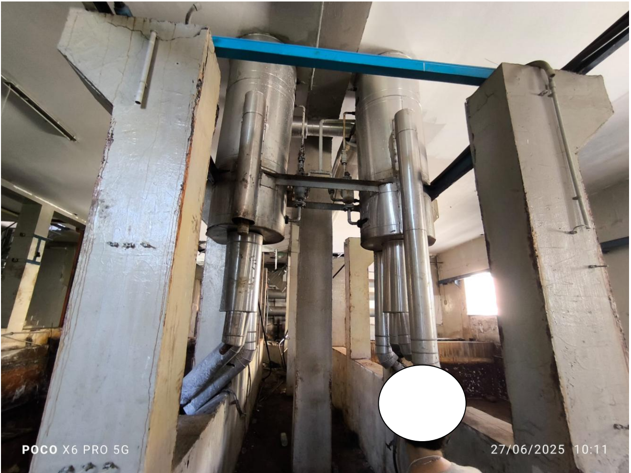
FOTO N. 17: Capannone Via Matilde Serao n. 21, “navata centrale”.
