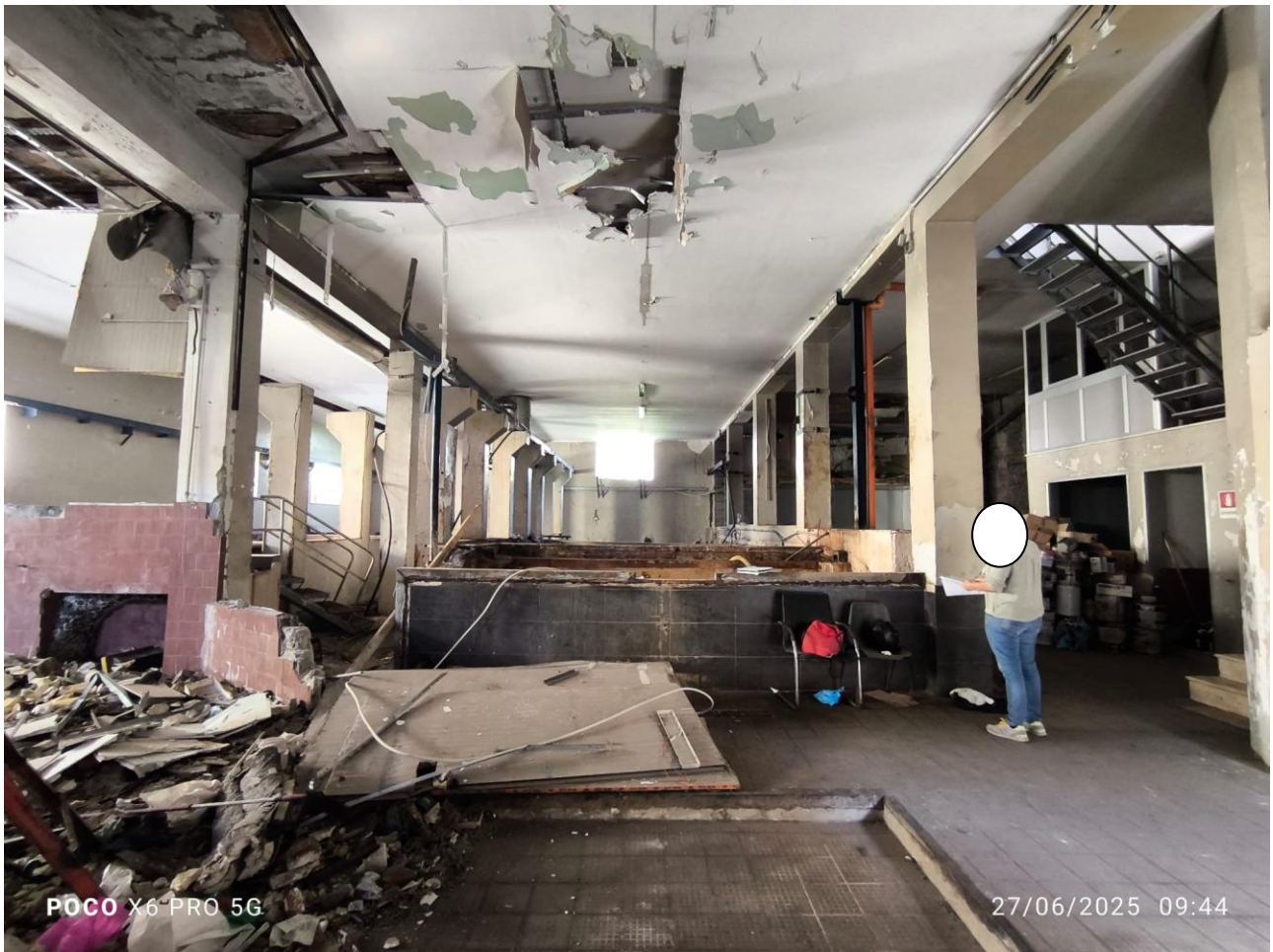
FOTO N. 4: Capannone Via Matilde Serao n. 21, si possono osservare le “tre navate” in cui risulta suddiviso il capannone dalla pilastratura esistente.
