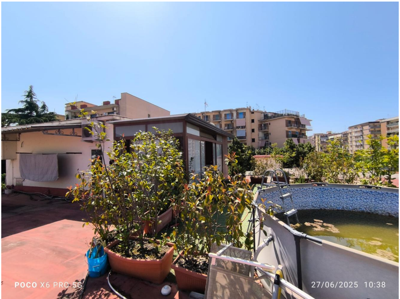
FOTO N. 23: Unità immobiliare, non oggetto di pignoramento, realizzata sull'estradosso della copertura e avente unico ed esclusivo accesso dall'interno del capannone mediante la scala in ferro.
