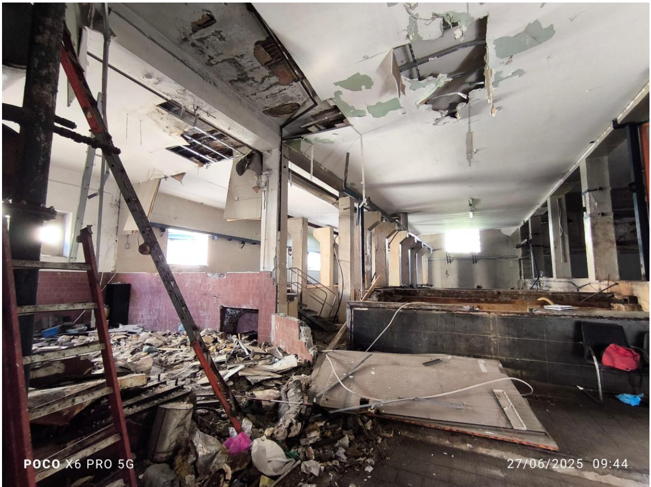
FOTO N. 5: Capannone Via Matilde Serao n. 21, si possono osservare le “tre navate” in cui risulta suddiviso il capannone dalla pilastratura esistente e le condizioni di degrado in cui lo stesso versa.
