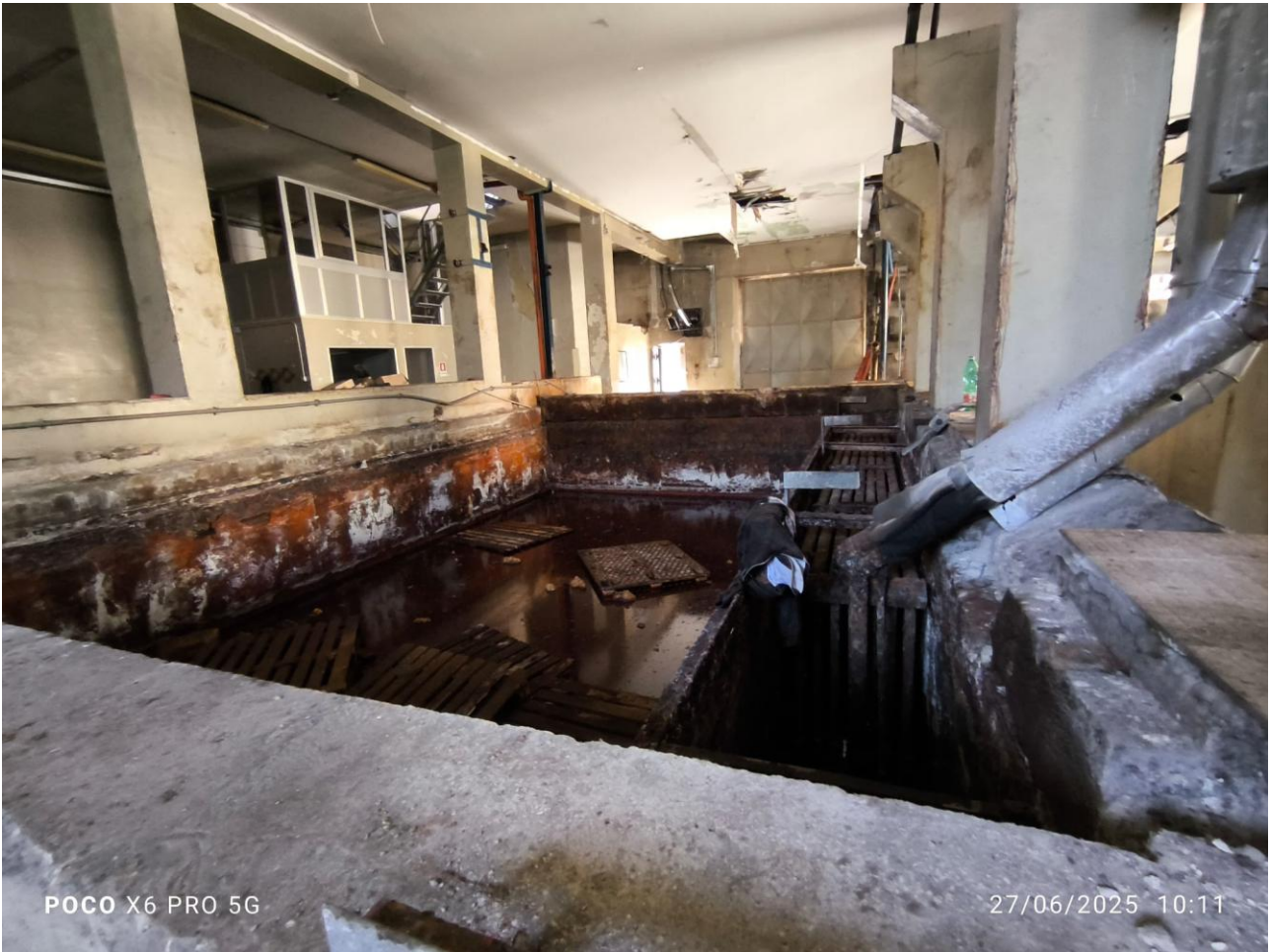
FOTO N. 16: Capannone Via Matilde Serao n. 21, “navata centrale”.
