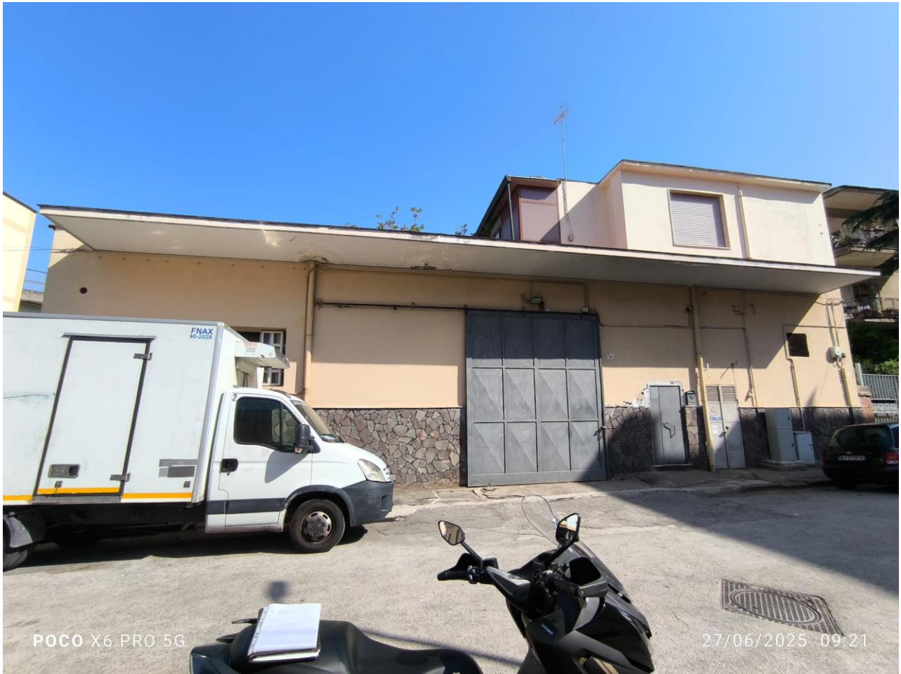
FOTO N. 1: Capannone Via Matilde Serao n. 21, ingresso carrabile e pedonale. Si può, altresì, osservare l'ingresso alla cabina ENEL (sulla destra) e l'unità immobiliare ad uso abitativo realizzata all'estradosso della copertura.
