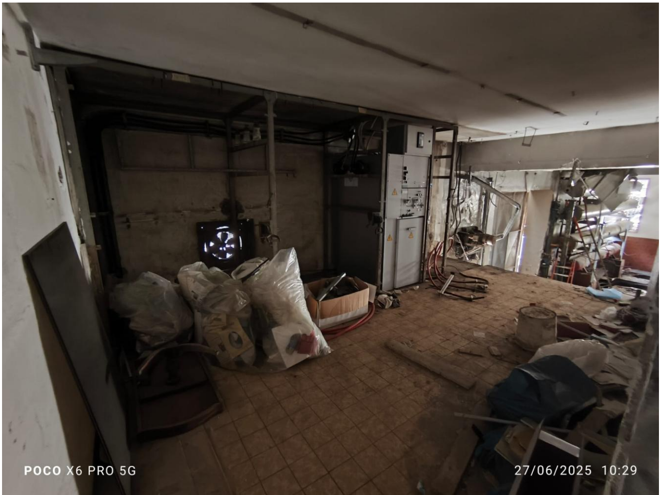
FOTO N. 11: Capannone Via Matilde Serao n. 21, “navata destra”, estradosso cabina ENEL.
