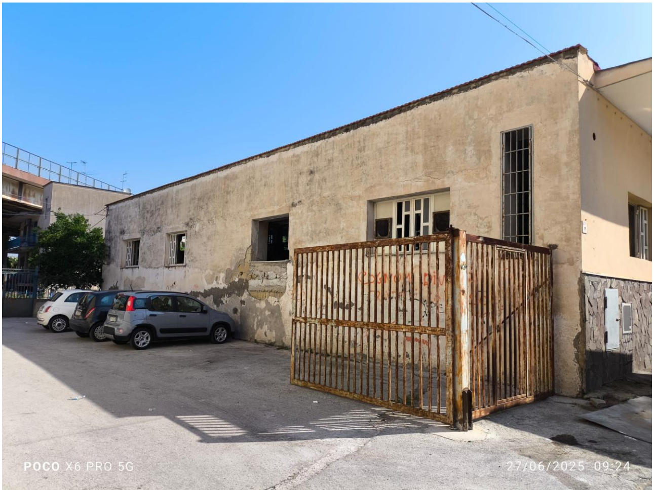
FOTO N. 3: Capannone Via Matilde Serao n. 21, prospetto ovest.
