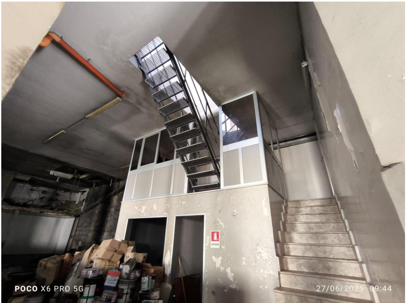
FOTO N. 7: Capannone Via Matilde Serao n. 21, “navata destra”. Si può osservare il blocco bagni e la scala di accesso all’estradosso della cabina ENEL e dei bagni. E’, altresì, visibile, la scala infero realizzata per consentire l’accesso (unico) all’unità abitativa realizzata sull’estradosso della copertura.
