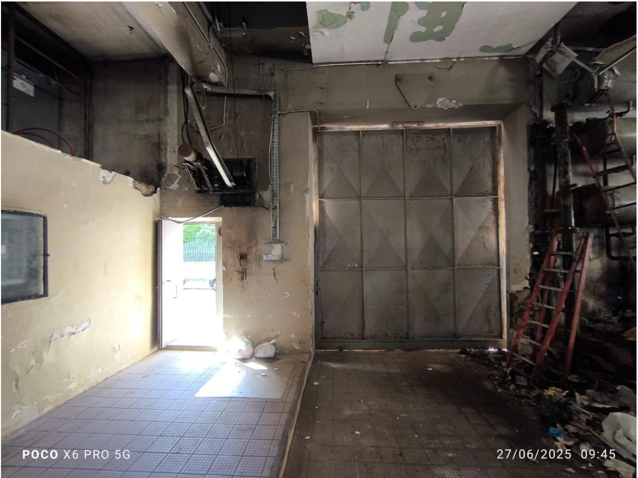
FOTO N. 13: Capannone Via Matilde Serao n. 21, ingresso carrabile e pedonale.
