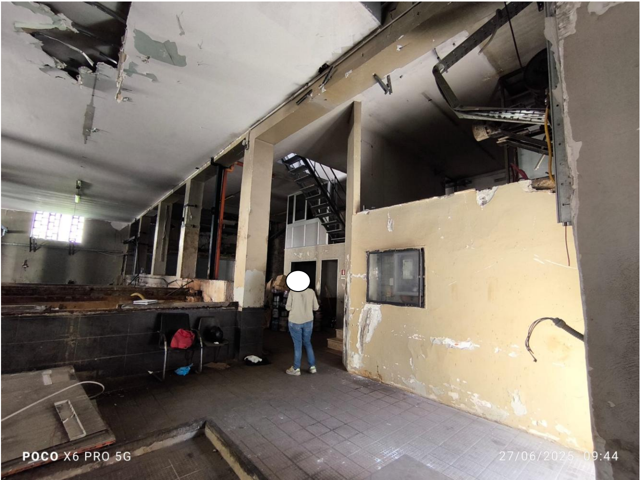
FOTO N. 6: Capannone Via Matilde Serao n. 21, “navata destra”. Si può osservare la cabina ENEL avente accesso solo dall’esterno mediante apposita porta in ferro.
