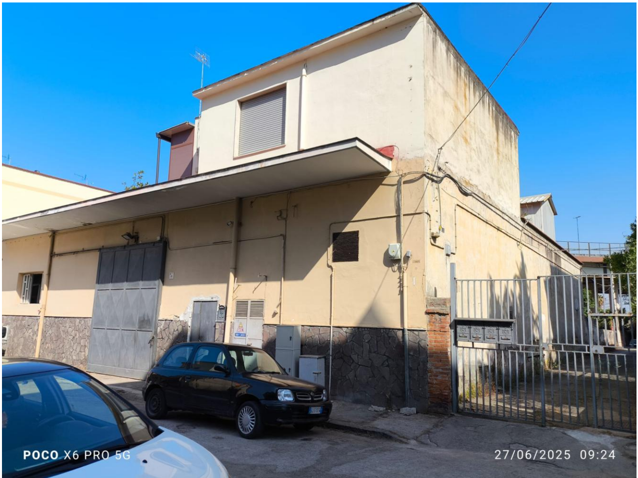
FOTO N. 2: Capannone Via Matilde Serao n. 21, ingresso carrabile e pedonale. Si può, altresì, osservare l'ingresso alla cabina ENEL (sulla destra) e l'unità immobiliare ad uso abitativo realizzata all'estradosso della copertura.
