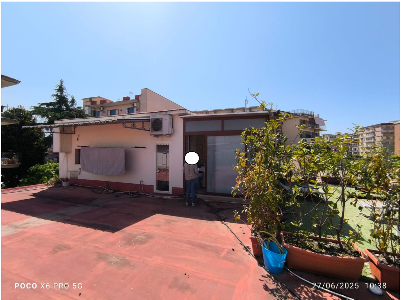
FOTO N. 22: Unità immobiliare, non oggetto di pignoramento, realizzata sull'estradosso della copertura e avente unico ed esclusivo accesso dall'interno del capannone mediante la scala in ferro.
