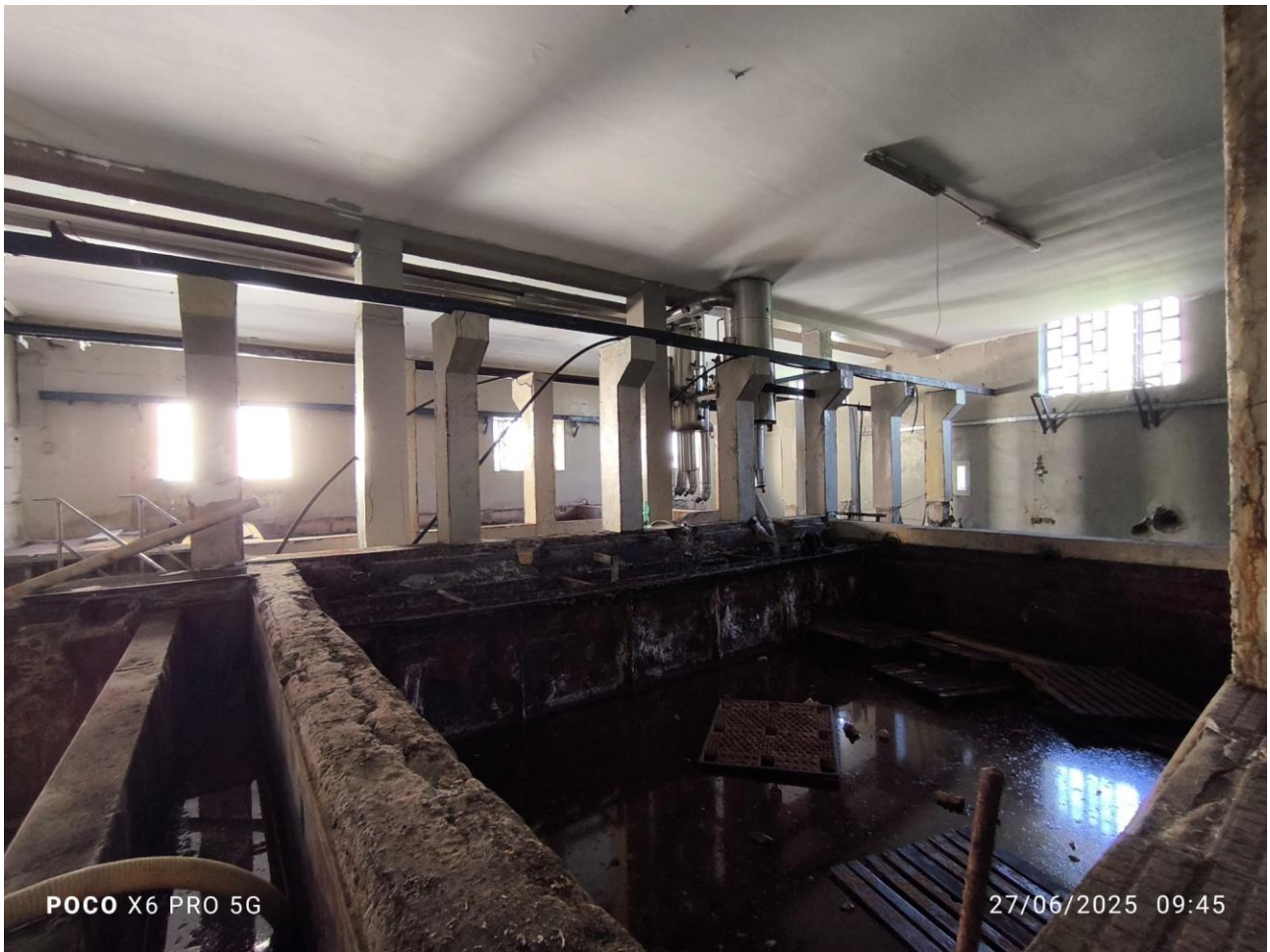
FOTO N. 15: Capannone Via Matilde Serao n. 21, “navata centrale”.
