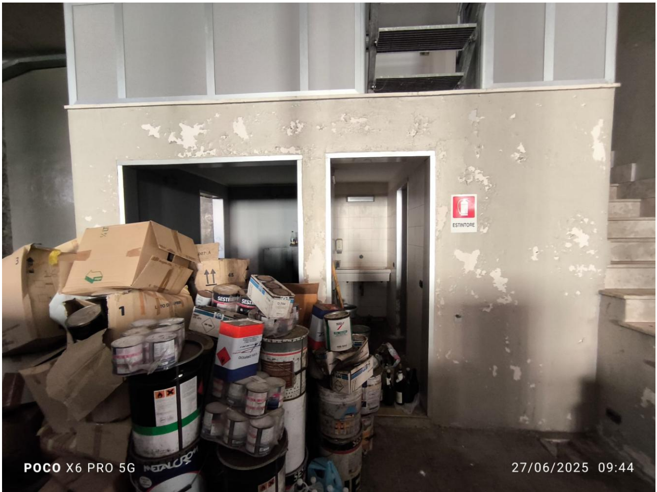
FOTO N. 8: Capannone Via Matilde Serao n. 21, “navata destra”, blocco bagni.
