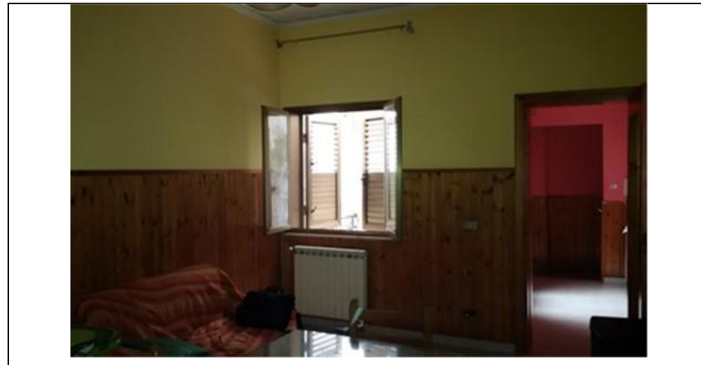
Foto 35 - vano soggiorno/cucina abusivo 1° piano
