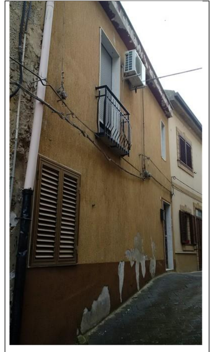
Foto 3- Prospetto con ingresso su via Messina n.4/6
