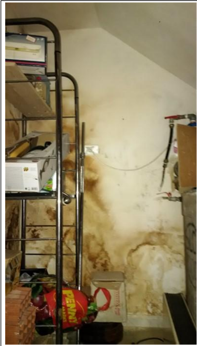
Foto 15 – vano sottoscala, piano seminterrato
