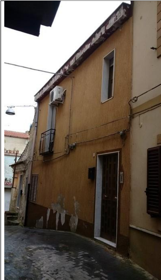
Foto 2 – Prospetto con ingresso su via Messina n.4/6
