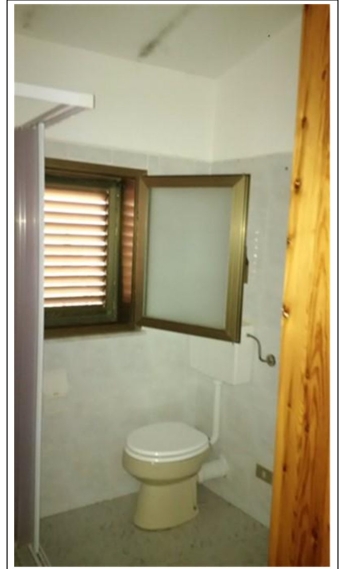
Foto 30- bagno/wc abusivo, 1° piano
