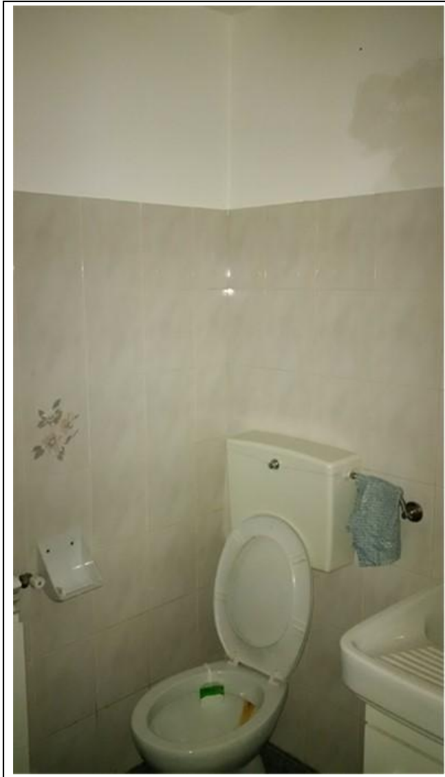
Foto 12 – vano w.c., piano seminterrato
