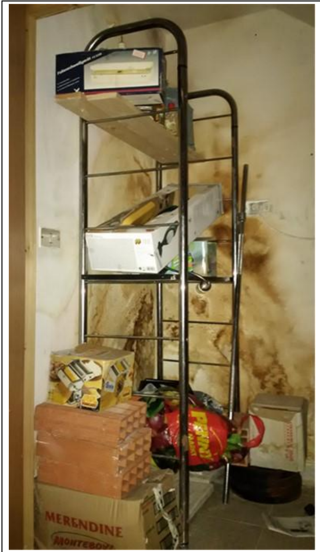
Foto 14 – vano sottoscala, piano seminterrato
