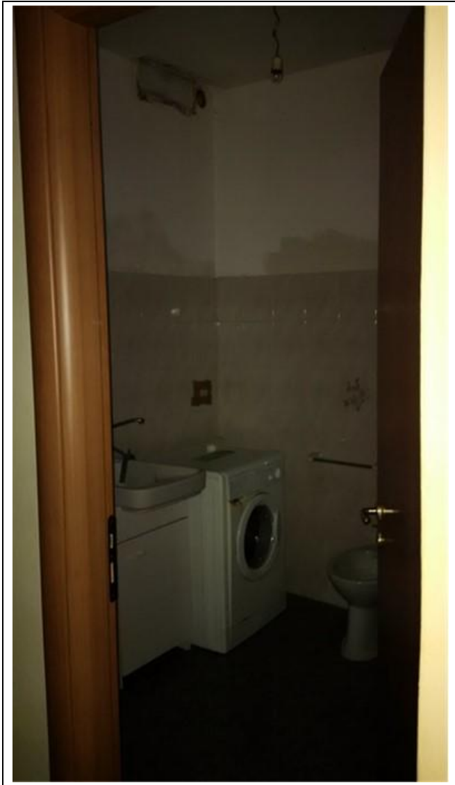
Foto 11 – vano w.c., piano seminterrato
