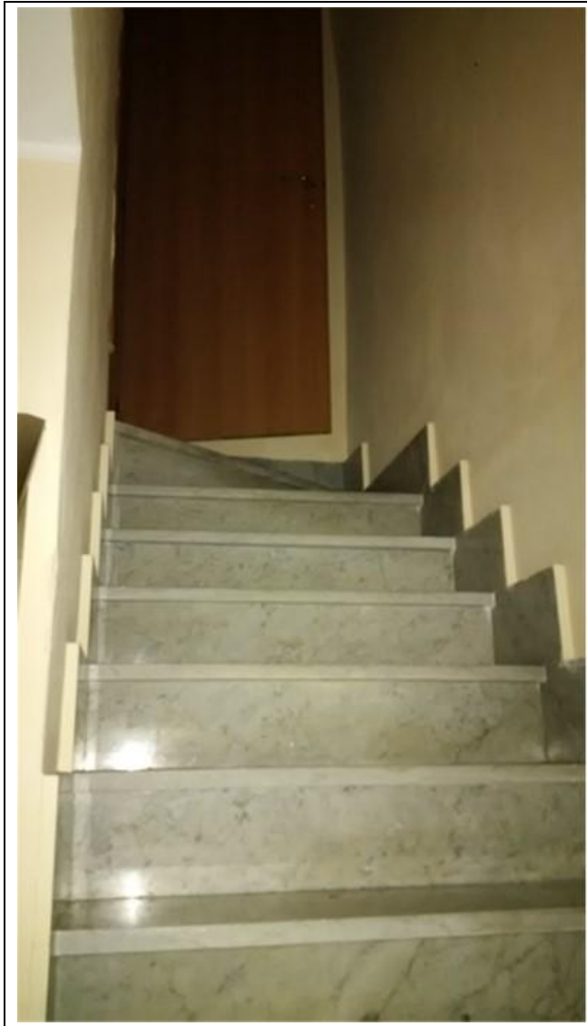
Foto 18 – vano scala, piano seminterrato
