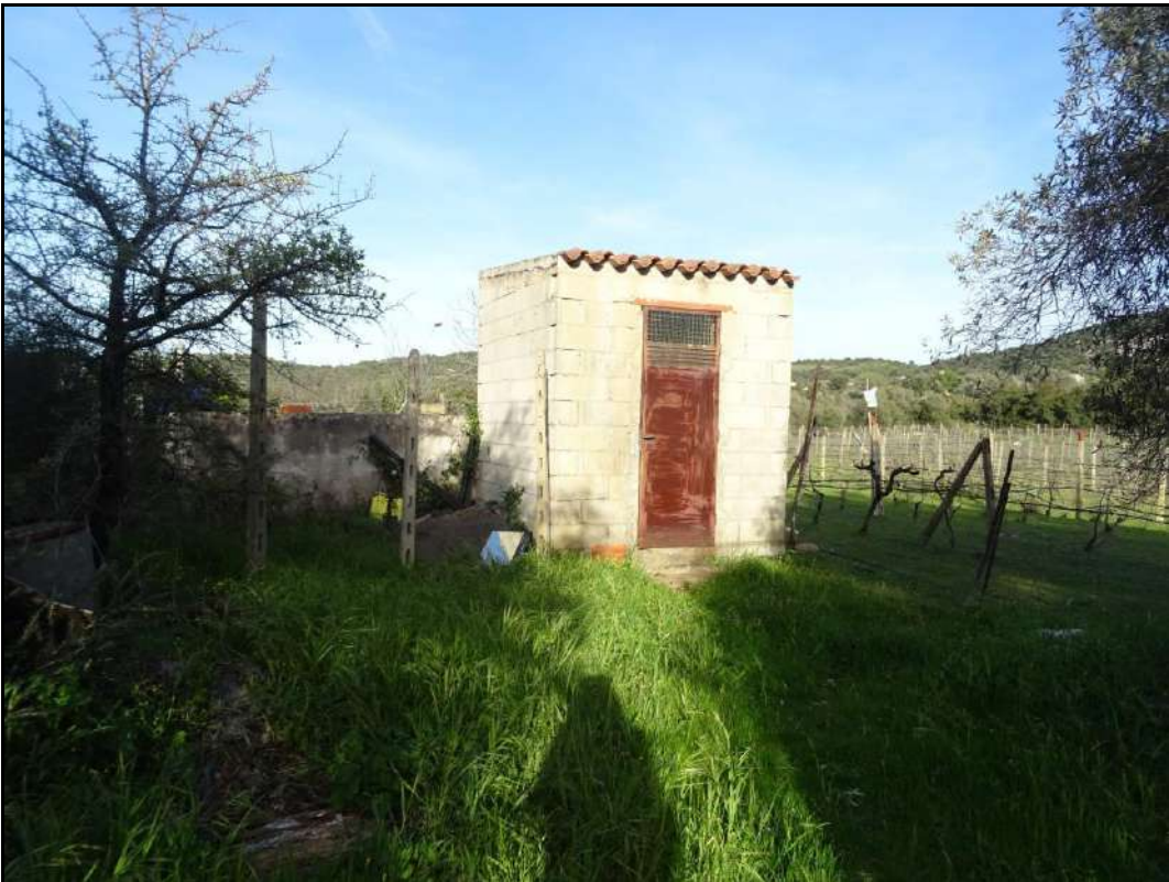
Vista locale tecnico
