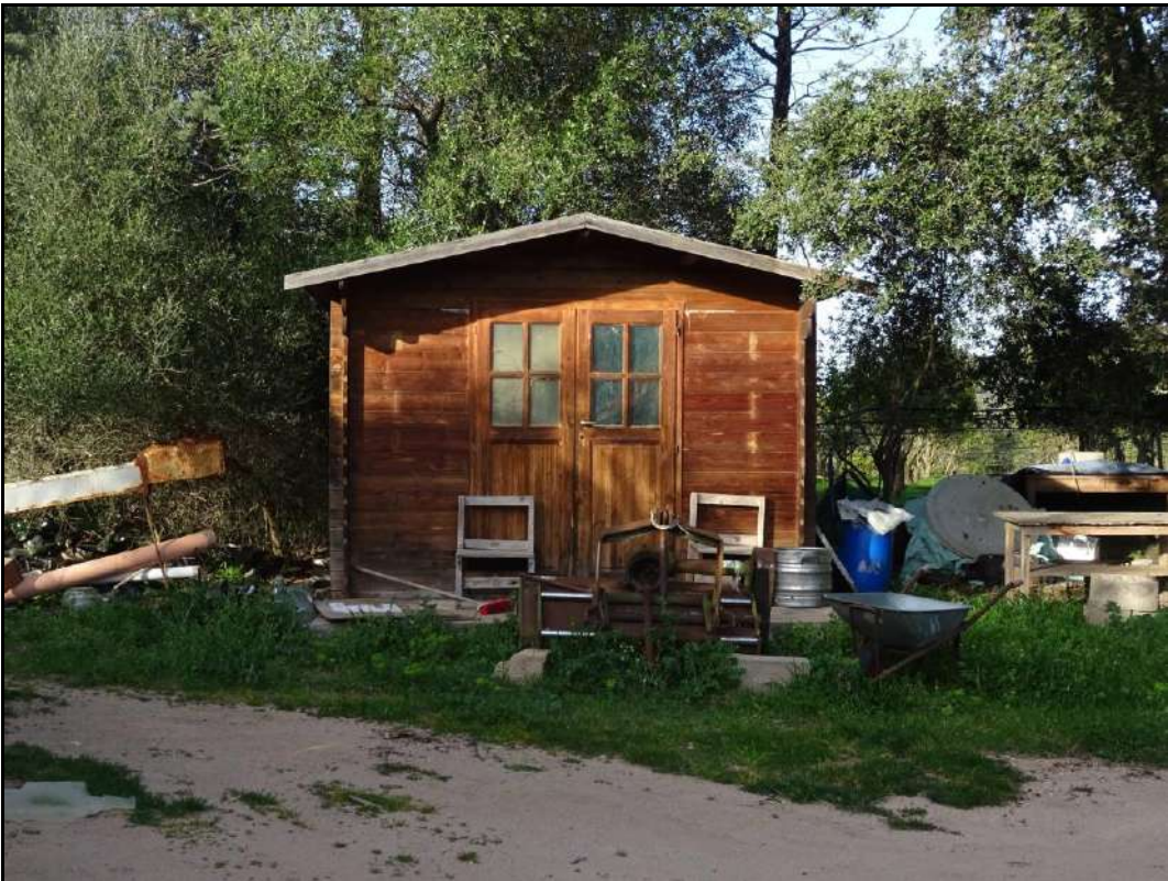
Vista immobile prefabbricato in legno
