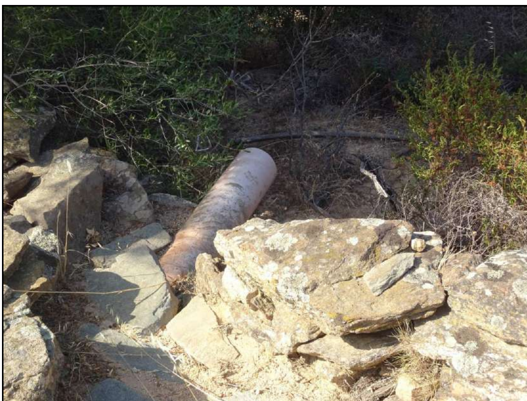
Vista scarico acque piovane nel lotto in esecuzione
