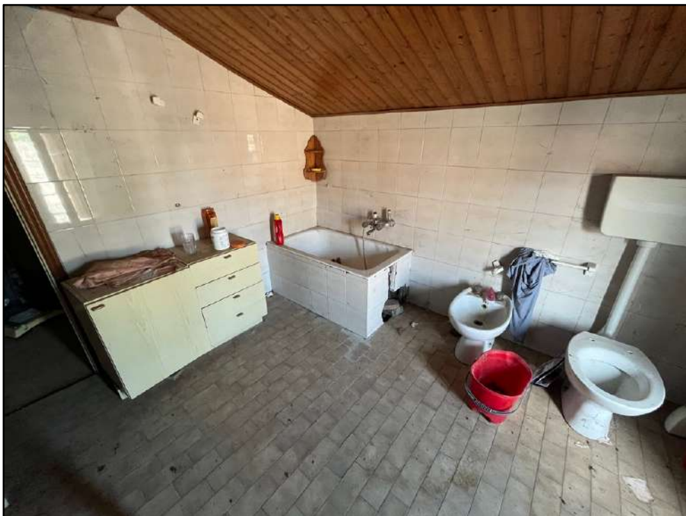
Foto 30: Piano Primo: il bagno – altra vista
