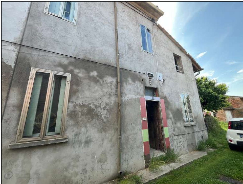
Foto 5: La facciata del bene pignorato
