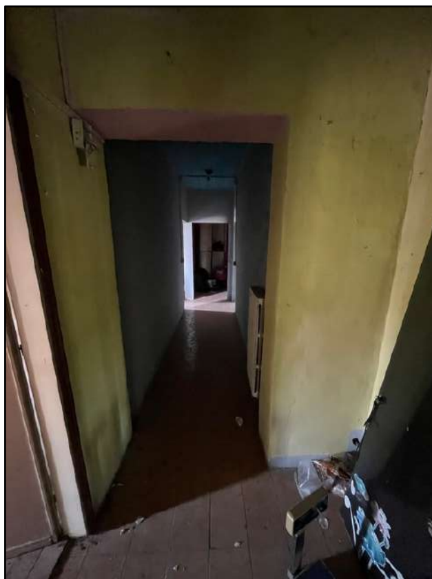
Foto 26: Piano Primo: il corridoio
