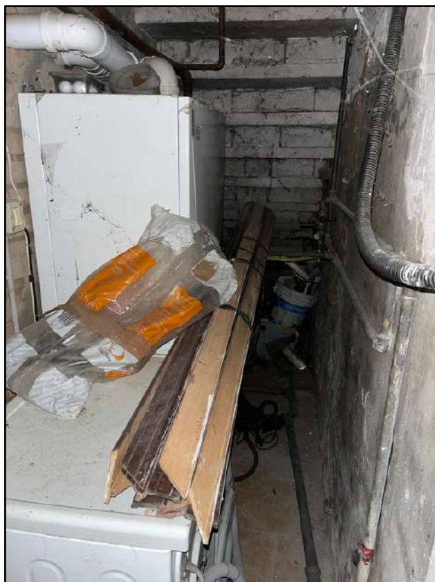
Foto 17: Piano Terra: il sotto scala
