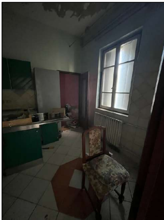
Foto 13: Piano Terra: ingresso alla cucina
