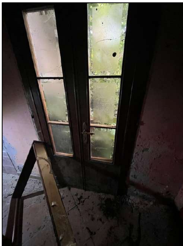
Foto 20: Piano Terra: La portafinestra che conduce al cortile di proprietà
