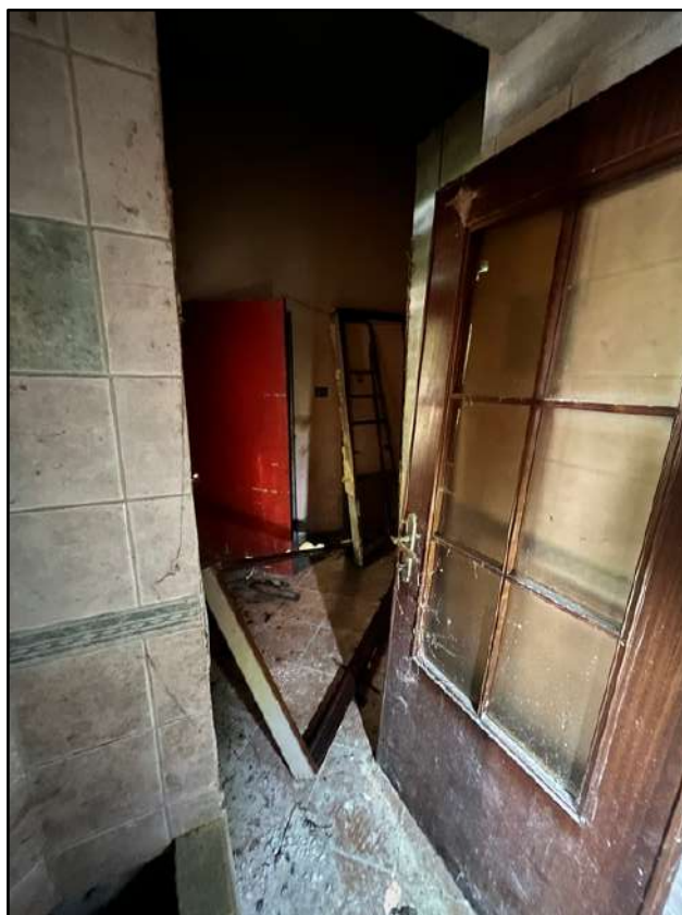
Foto 18: Piano Terra: altra vista della stanza passante
