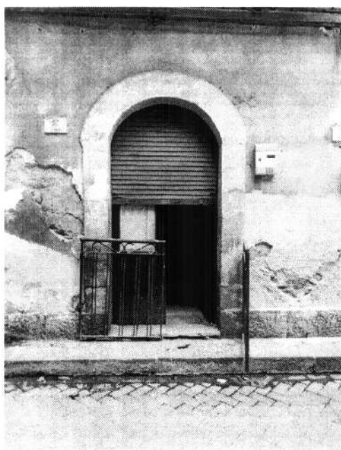
Porta d'ingresso su via A. Saffi n. 60
