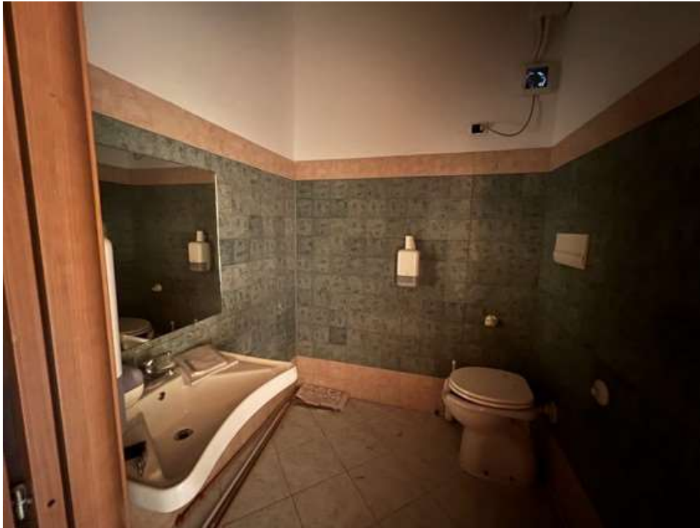
Fotografia E.11 - Bagno 1
