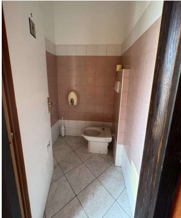
Fotografia E.13 - Bagno 3
