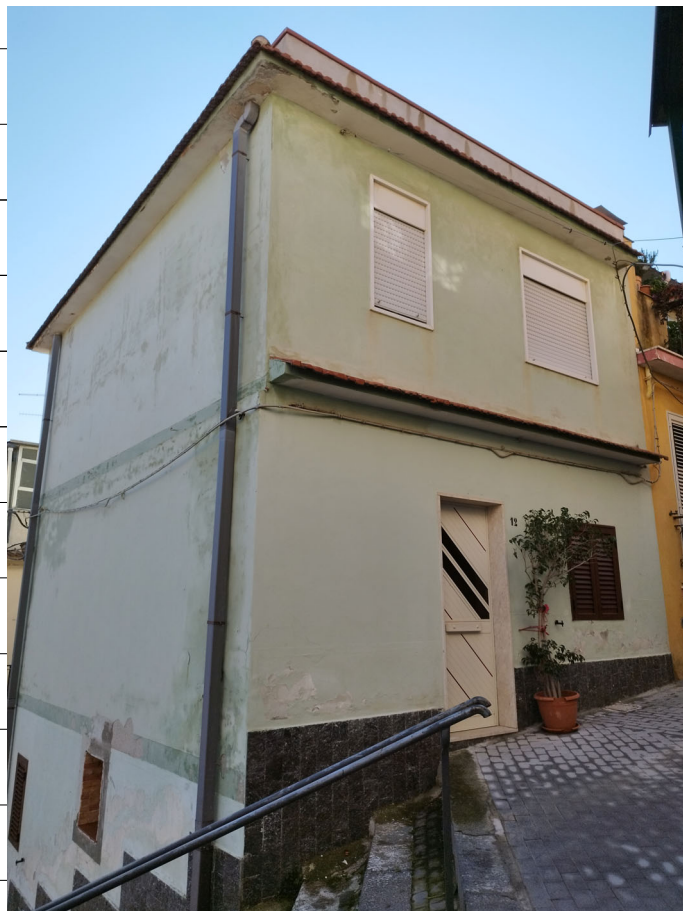
Foto 4 - Prospetto su Via Bafumi
