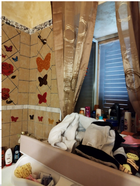
Foto 14 - Finestra del bagno al Piano primo
