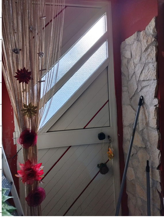
Foto 11 - Ingresso al Piano primo su Via Bafumi
