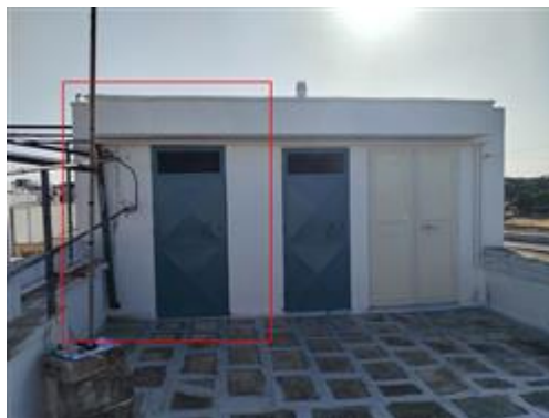
2 - "LOTTO 1" - LATIANO - vista esterna del vano tecnico al piano 2° (lastrico solare comune)
