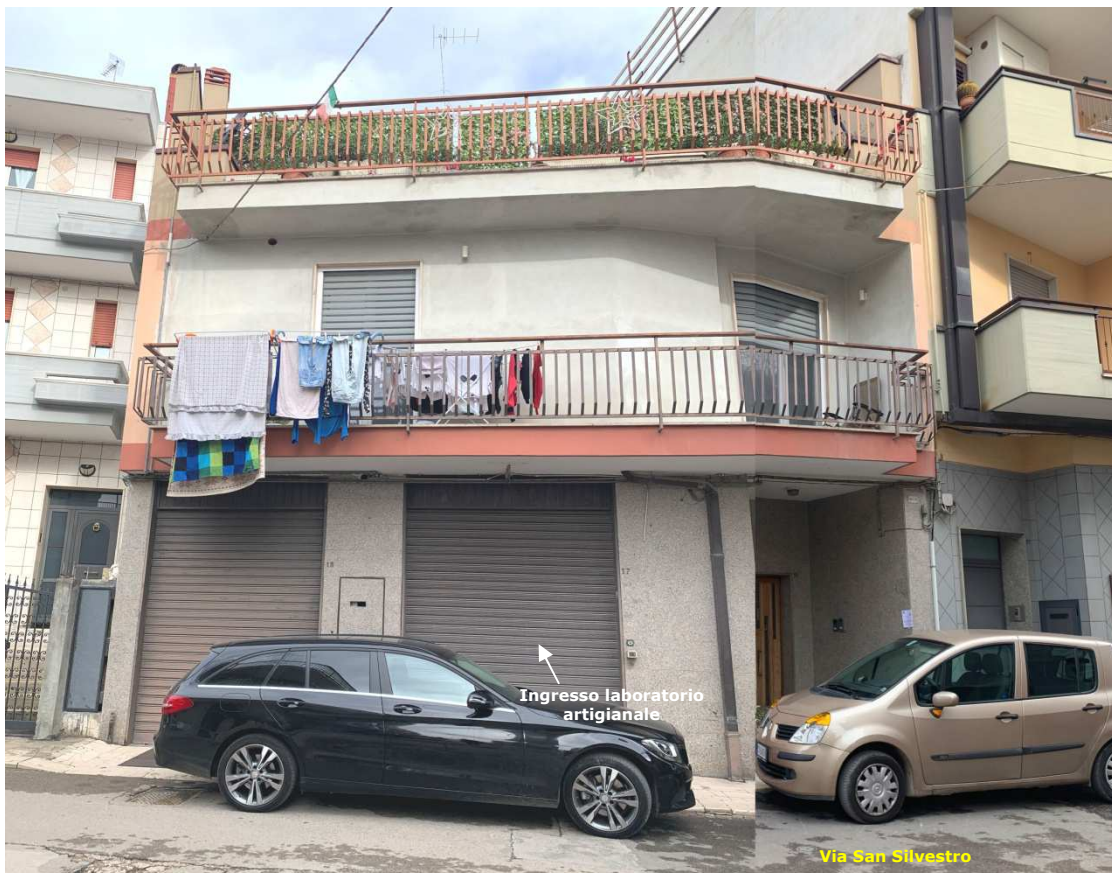
Foto n. 1. Locale laboratorio artigianale al piano terra e locali deposito al piano interrato, siti in Altamura alla Via San Silvestro nn. 17-19
