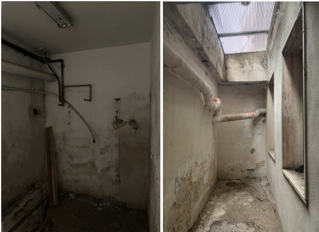
Foto nn. 26-27. Piano Interrato. Vano deposito 2 ed intercapedine (vano deposito 1)
