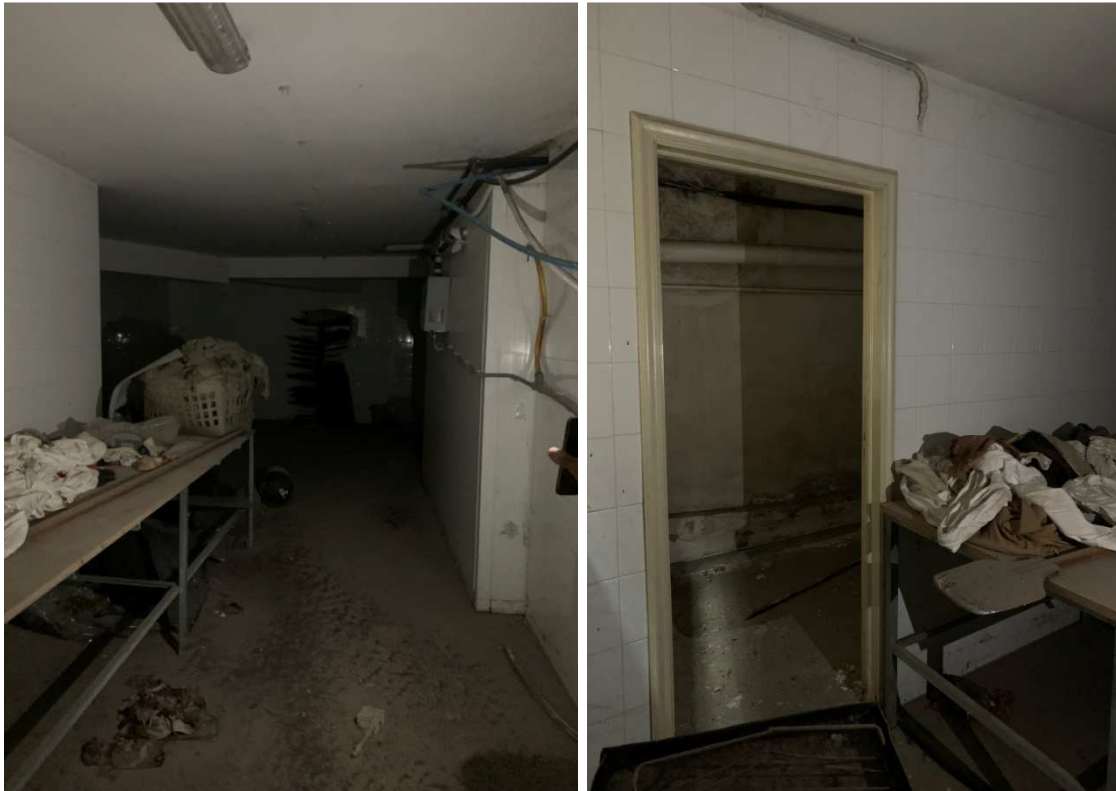
Foto nn. 24-25. Piano Interrato. Vano deposito 1 e vano deposito 2
