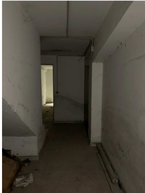
Foto nn. 20-21. Piano Interrato. Montacarichi e disimpegno
