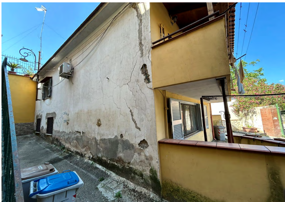
FOTO 4 Prospetto del fabbricato sul retro (lato est)
