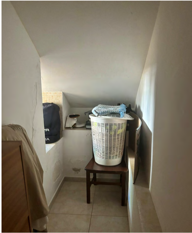
FOTO 11 Appartamento al PT SUB 7: Ripostiglio (sottoscala)
