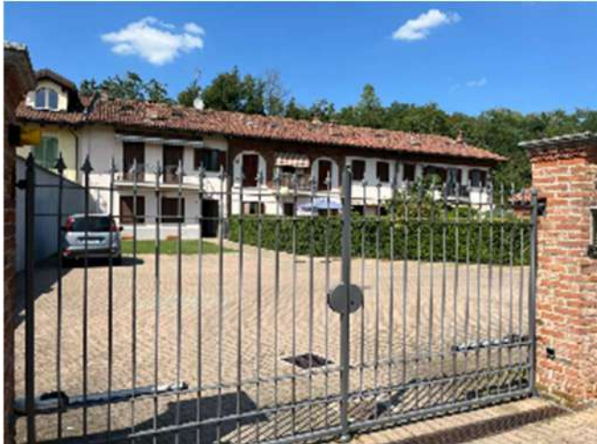
Fabbricato via Borgo Valentino 28 e antistante area comune
