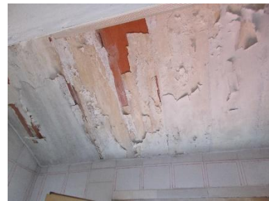
Soffitto del bagno
