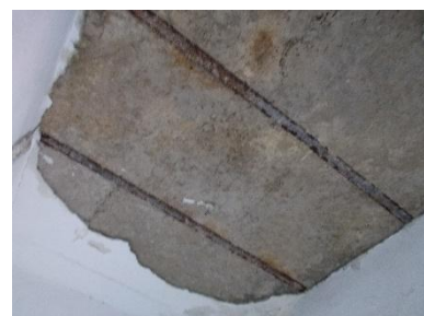
Soffitto della cucina
