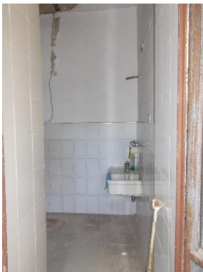
Rivestimento e pavimento della cucina
