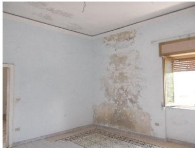
Finestra e parete della prima camera
