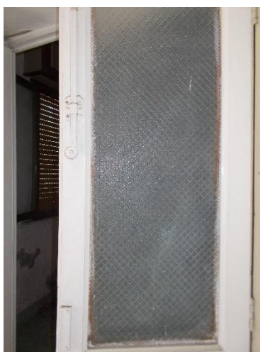
Dettaglio delle porte interne
