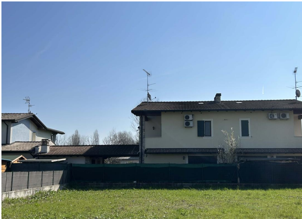
Foto n. 4 – Vista posteriore (Ovest)
