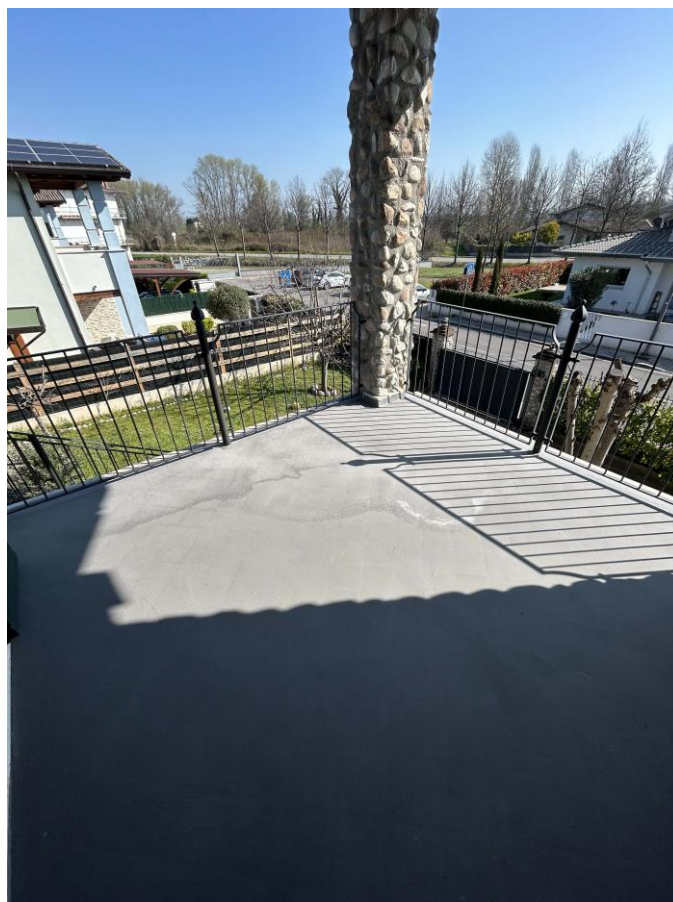
Foto n. 16 – Appartamento – Piano I° – Portico accessibile da disimpego
