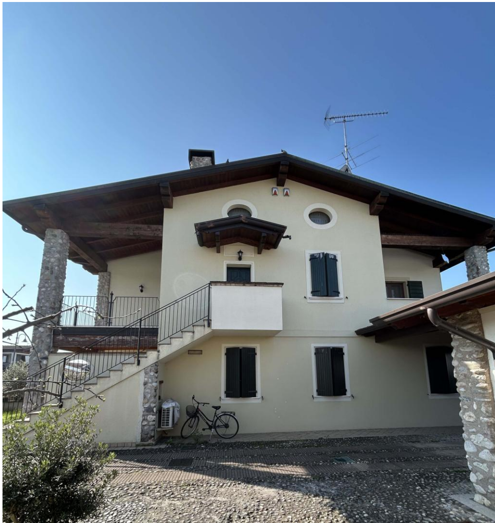
Foto n. 3 – Vista laterale (Nord)
