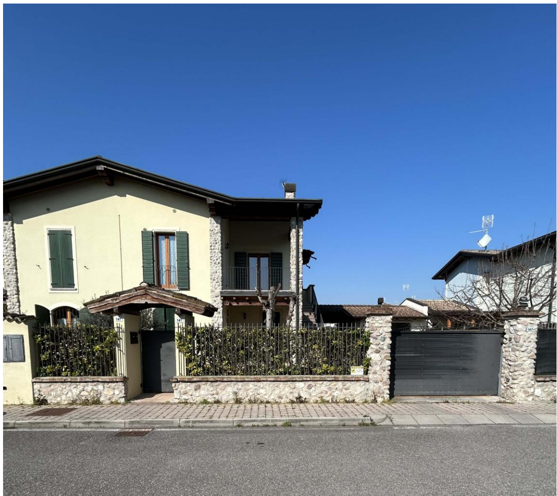
Foto n. 2 – Vista frontale (Est)
