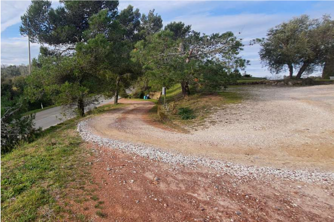
Foto n°21 (strada di accesso)
