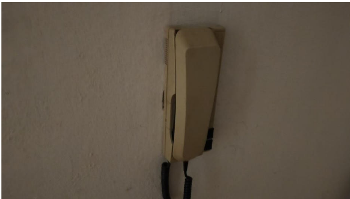
FOTO 17: : Vista impianto elettrico
