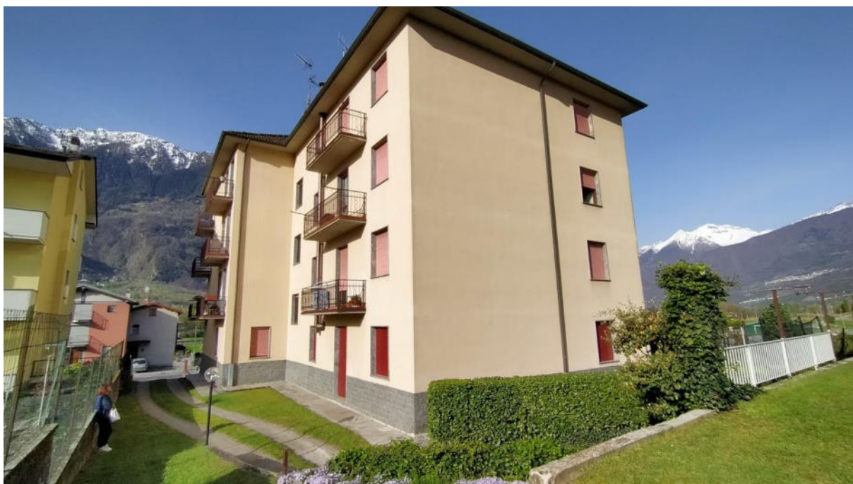
FOTO 2: Fronte nord- est
