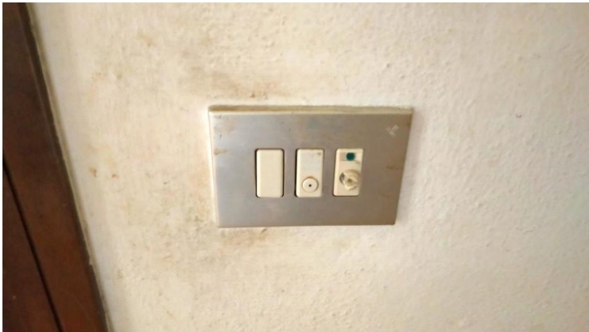
FOTO 16: : Vista impianto elettrico
