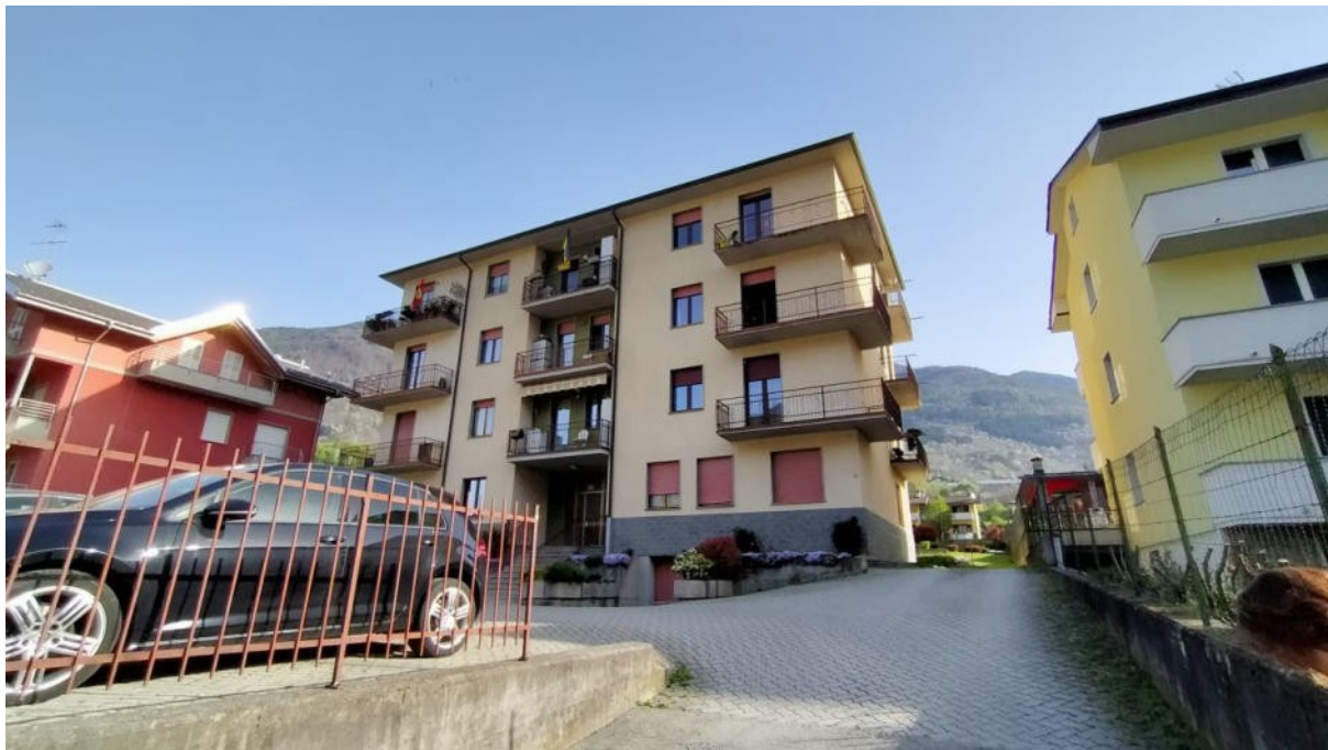
FOTO 1: Fronte sud - ovest
