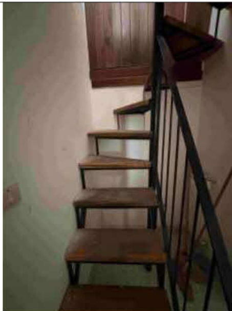
Piano Primo – Vista scala di accesso al piano II
