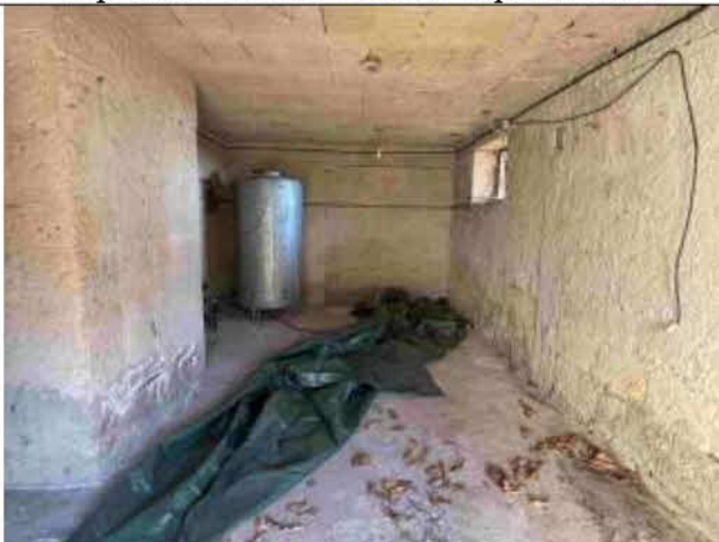
Piano seminterrato - Vista locale deposito 1
