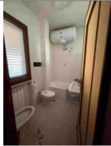
Piano Primo – Vista w.c. 2
