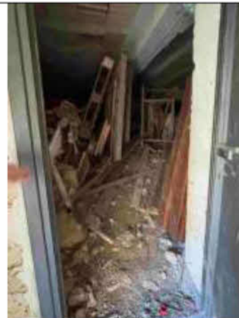
Piano seminterrato - Vista locale deposito 2
