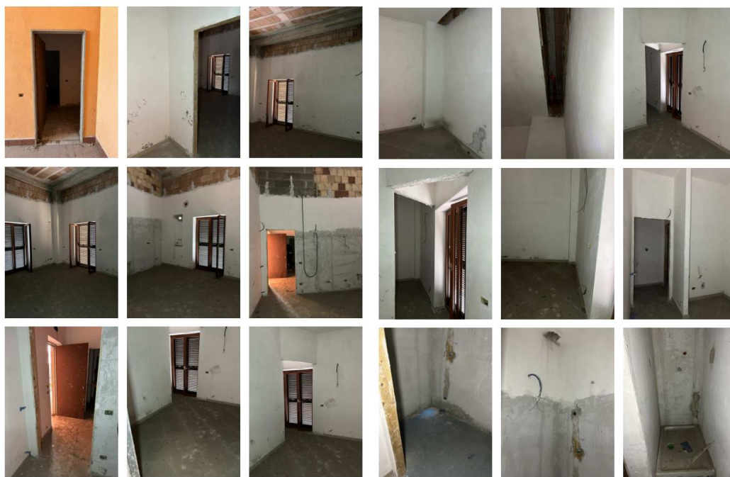
Estratto repertorio fotografico del sub 8
