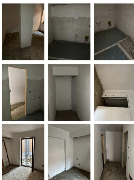
Estratto repertorio fotografico del sub 3
