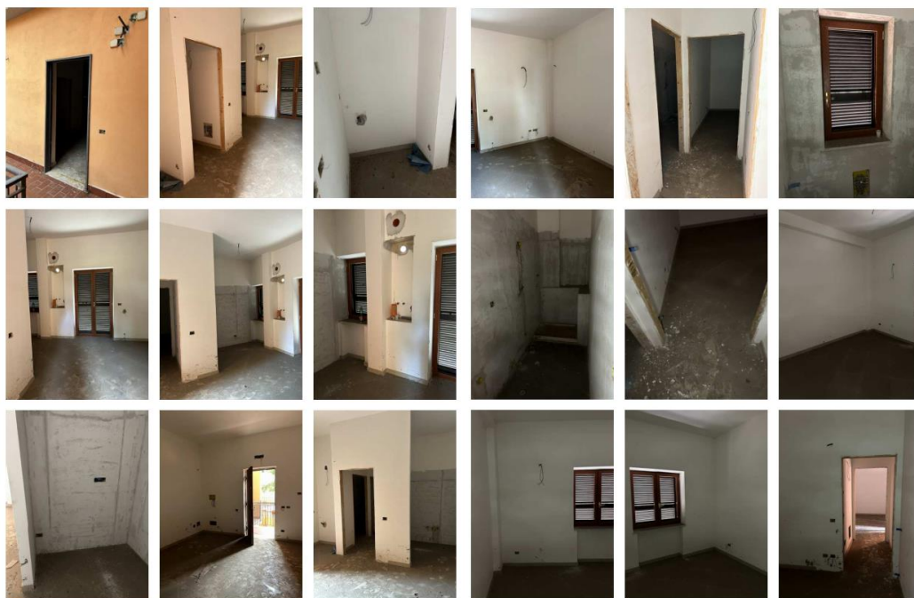
Estratto repertorio fotografico del sub 9
