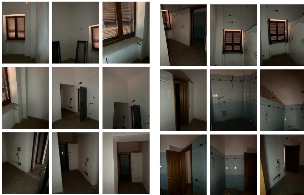
Estratto repertorio fotografico del sub 6
