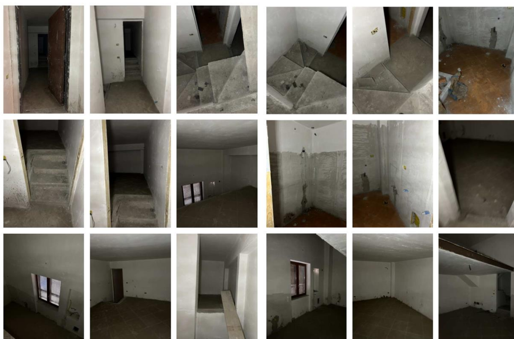
Estratto repertorio fotografico del sub 2
