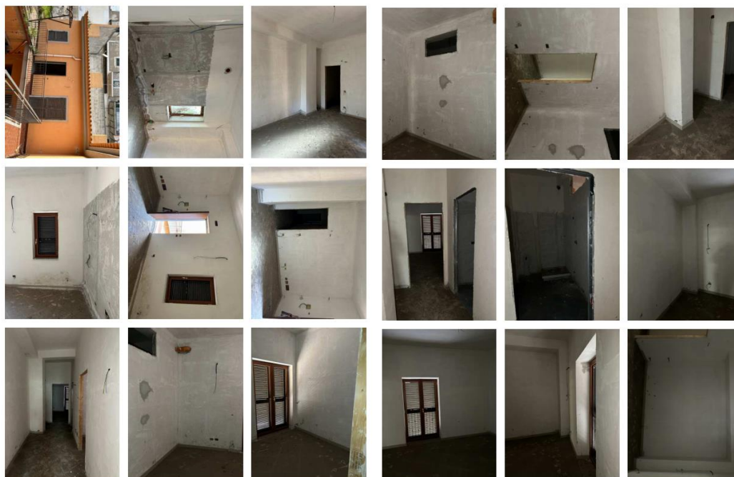
Estratto repertorio fotografico del sub 10
