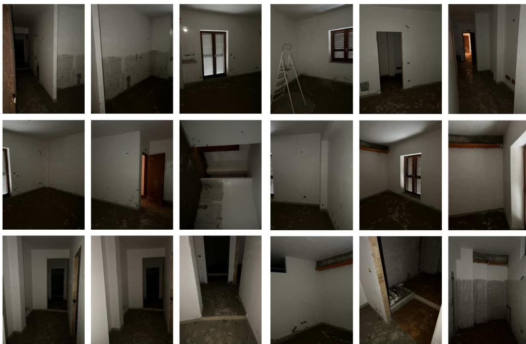
Estratto repertorio fotografico del sub 5
