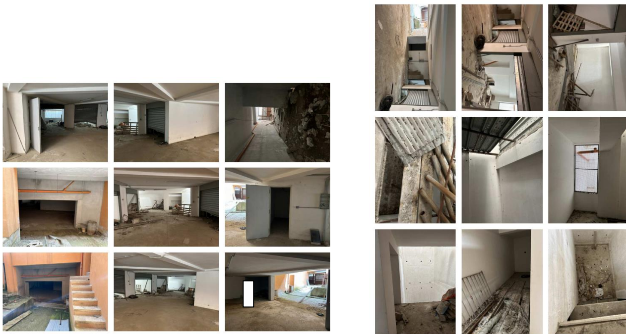
Estratto repertorio fotografico del corpo box auto al piano terra
