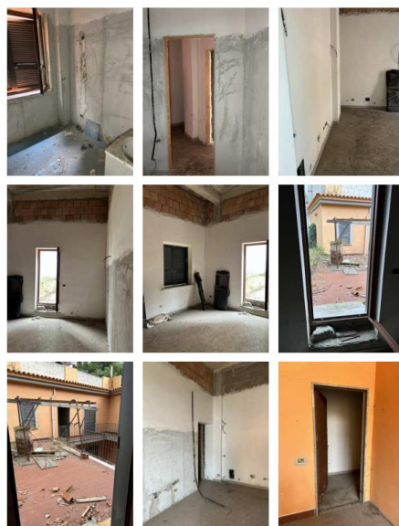
Estratto repertorio fotografico del sub 7
