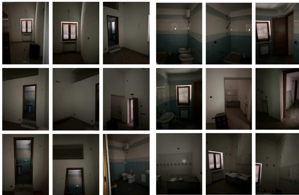
Estratto repertorio fotografico del sub 7
