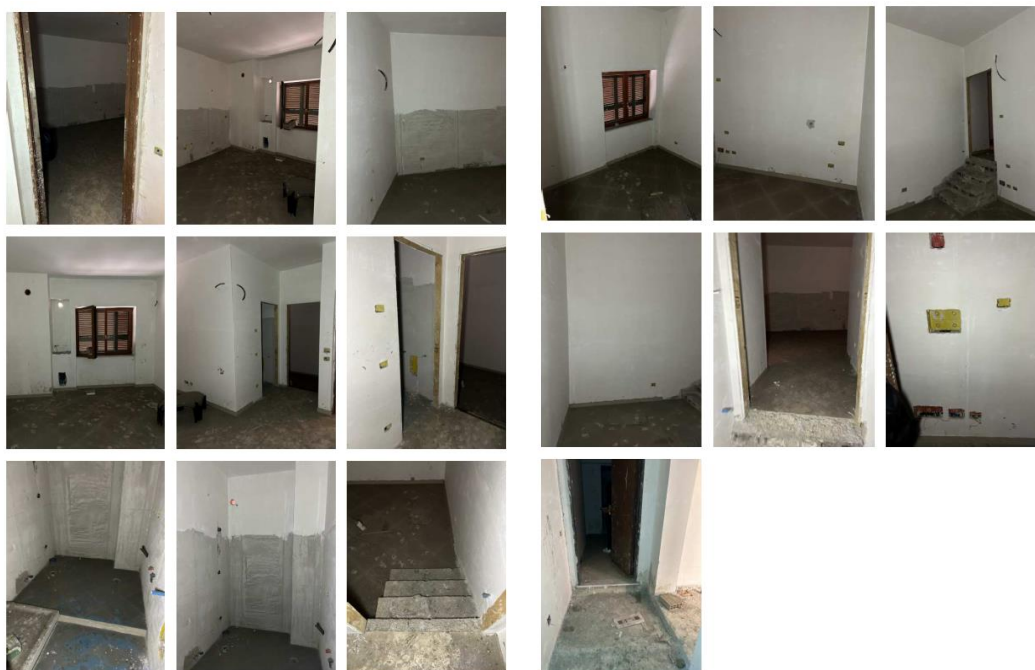
Estratto repertorio fotografico del sub 1
