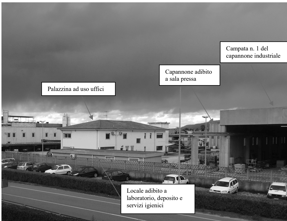
Foto n. 1: Lotto n. 1 fotografato dal piazzale Nord.
