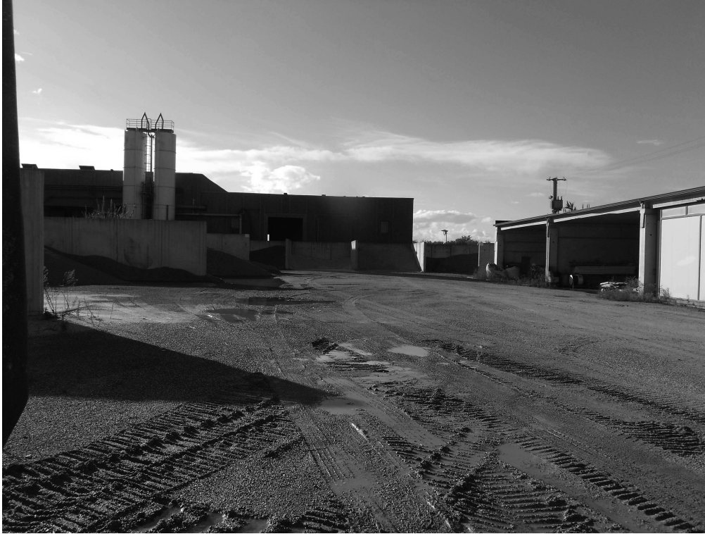
Foto n. 2: Tettoie e locali deposito ubicate nel lotto n. 1.
