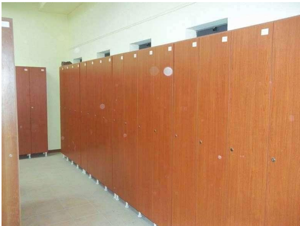
Foto n. 203: n. 130 armadietti per spogliatoio operai
