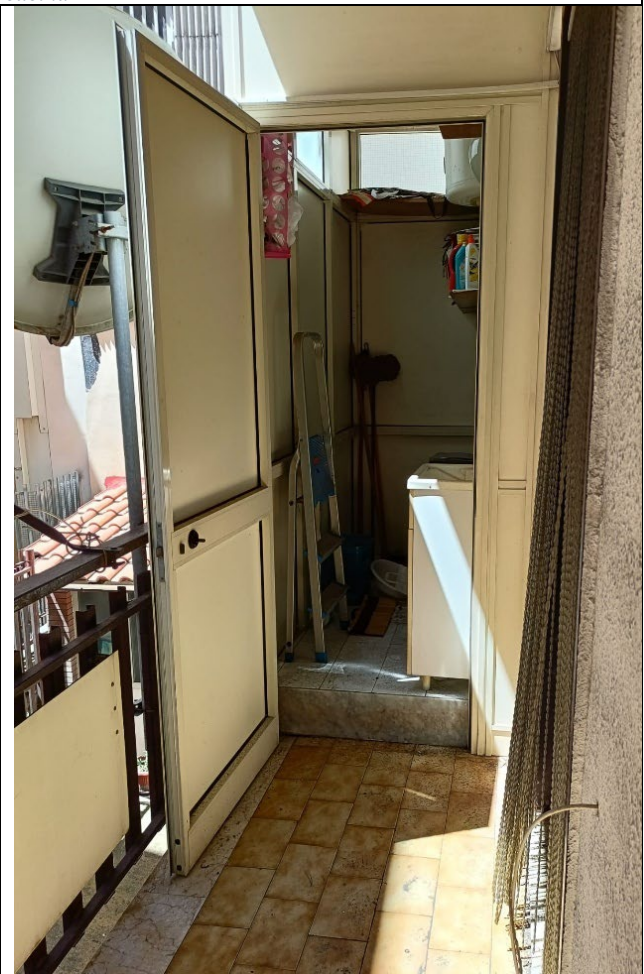
Foto 11 balcone lato Sud chiusura per lavanderia vista Ovest
