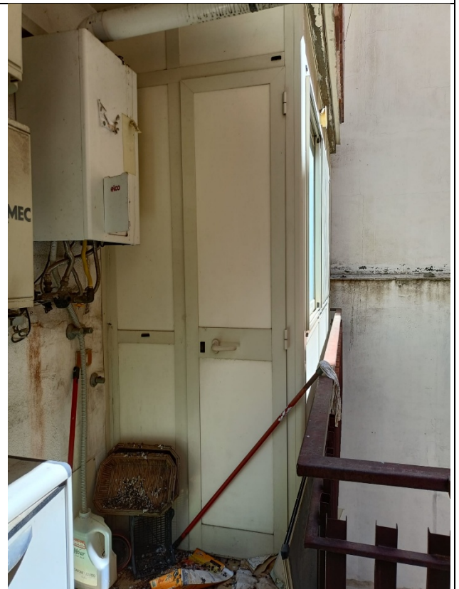
Foto 21 balcone lato Sud dettaglio chiusura per bagno
