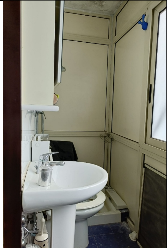
Foto 19_bagno su balcone camera padronale
