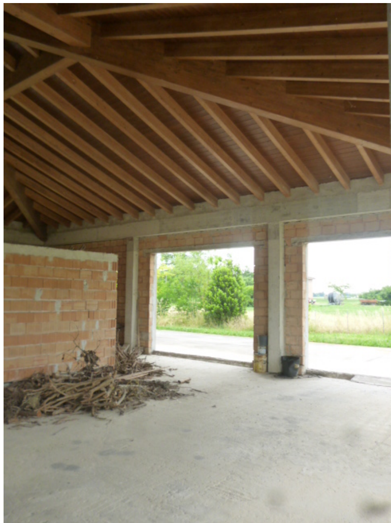
VISTA FABBRICATO INTERNO
