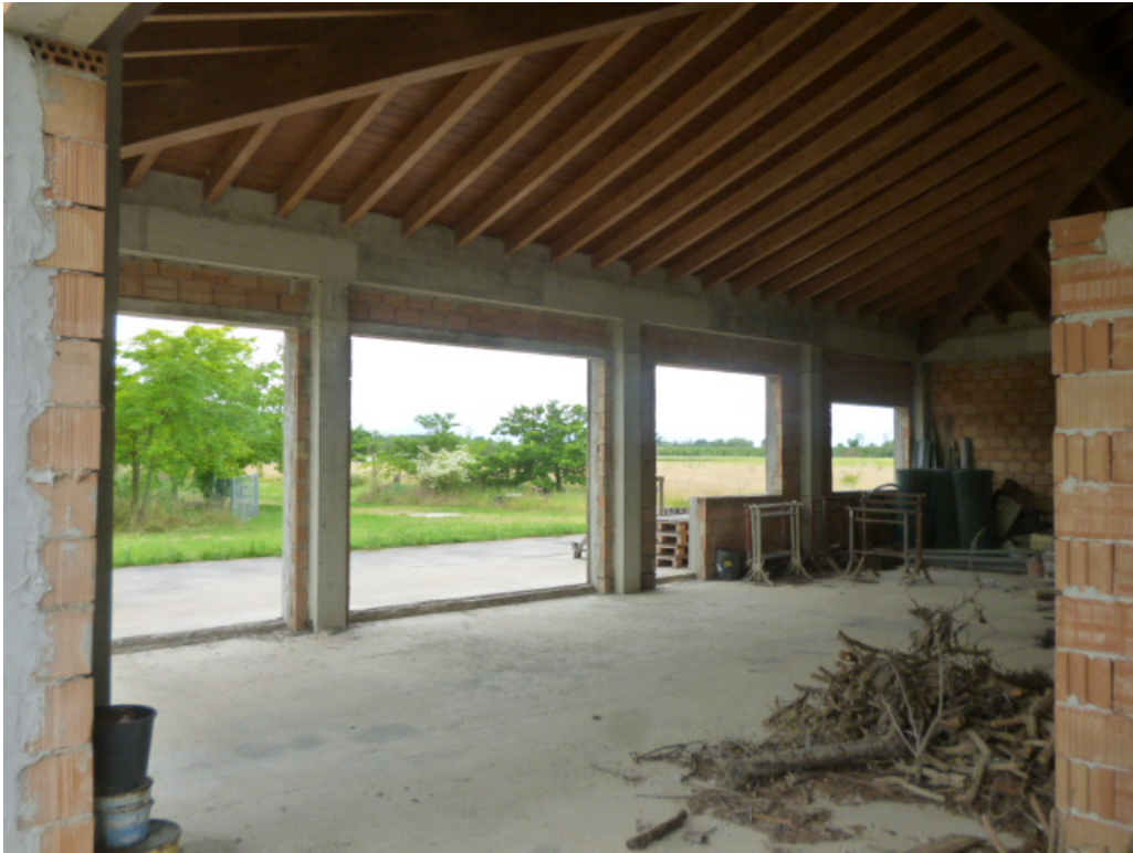
VISTA FABBRICATO INTERNO
