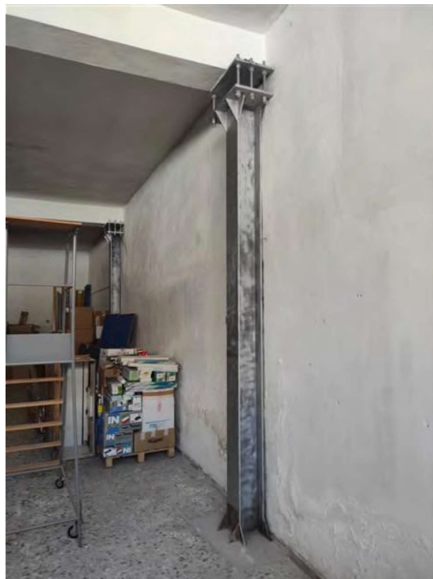
Lotto 1 – Pilastro di rinforzo in acciaio
