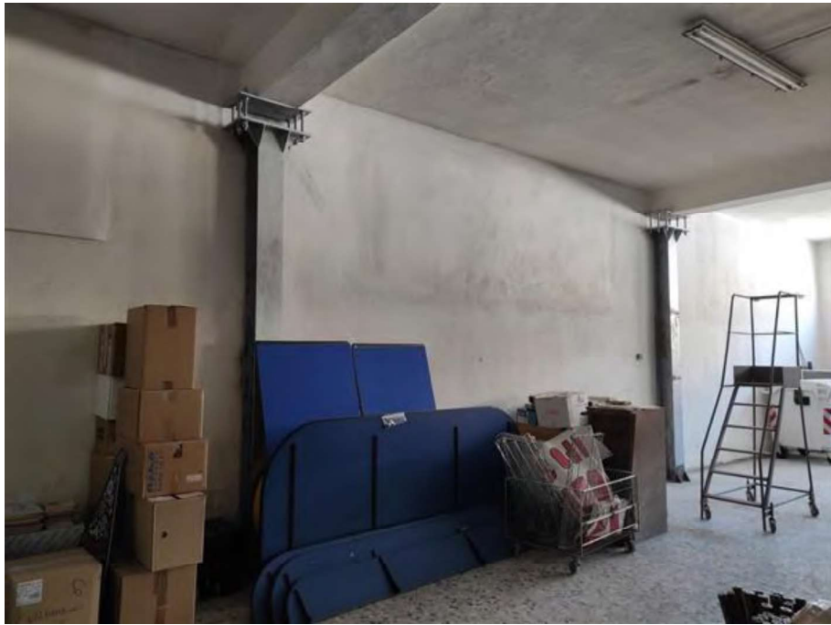
Lotto 1 – Pilastrini di rinforzo in acciaio
