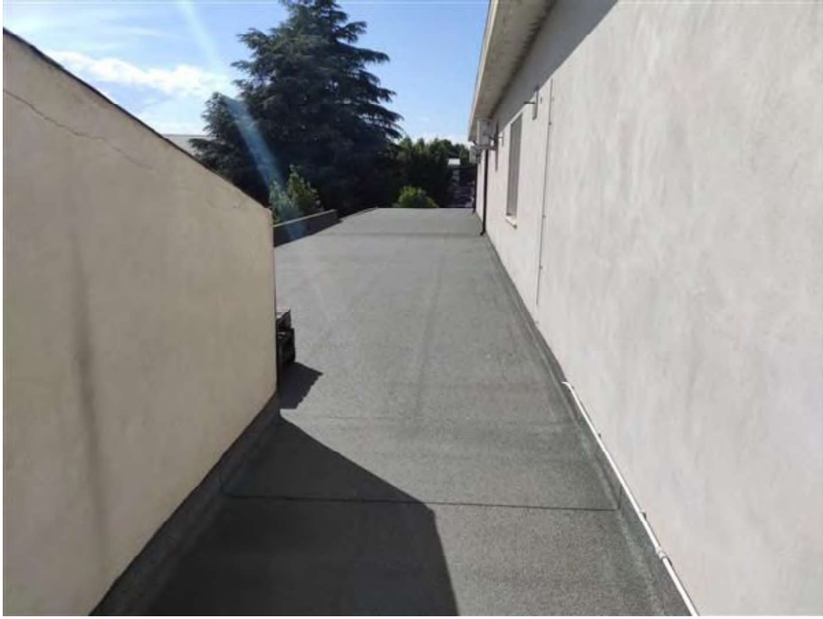
Lotto 2 – Lastrico solaio al piano primo
