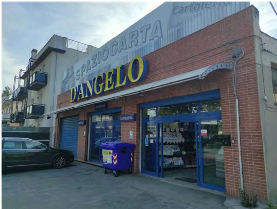
Vista prospetto principale
