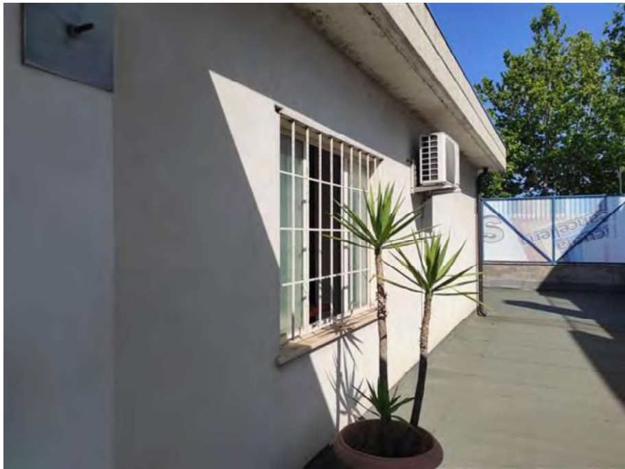
Lotto 2 – Lastrico solaio al piano primo
