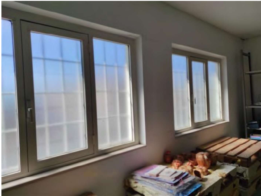
Lotto 2 – Vista interno locale
