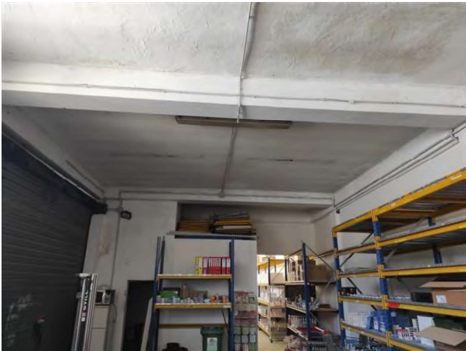
Lotto 1 – Vista interno locale
