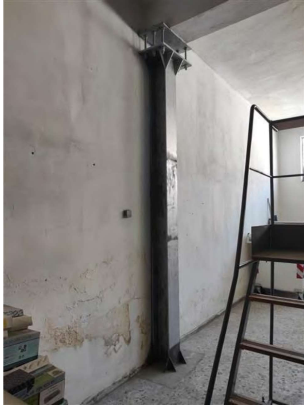
Lotto 1 – Pilastrino di rinforzo in acciaio
