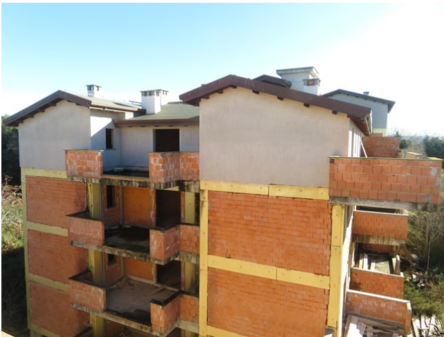
Fronte laterale - vista da un appartamento della Palazzina B
