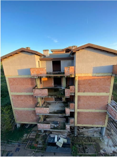
Fronte laterale - vista da un appartamento della Palazzina B
