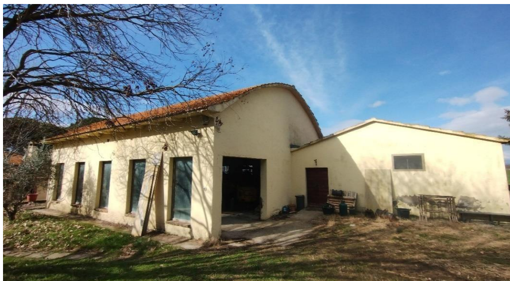
LOTTO 3 - FOTO N. 18 – P.LLA 344 – VISTA GEN. CON INGRESSO
