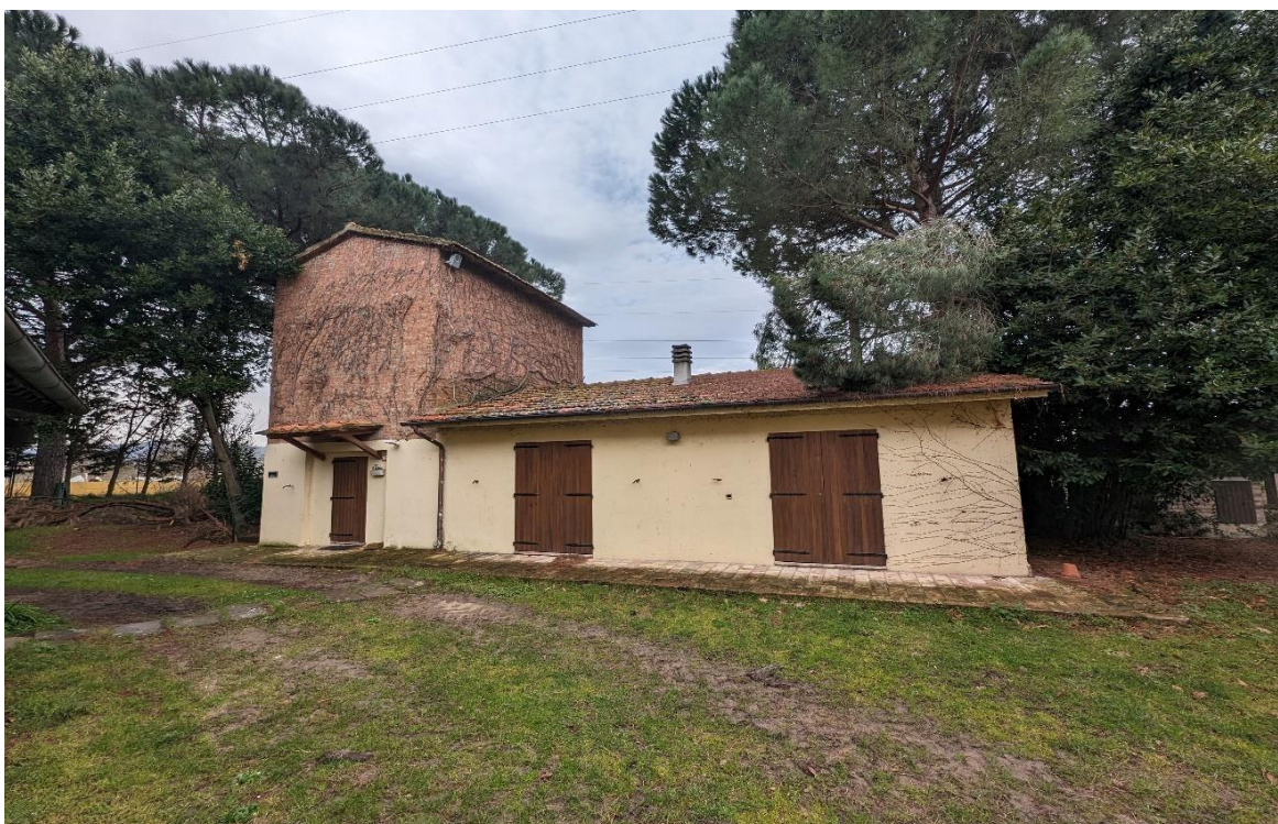
LOTTO 4 – FOTO 24 – P.LLA 227- VISTA GEN. CASA “TORRE”
