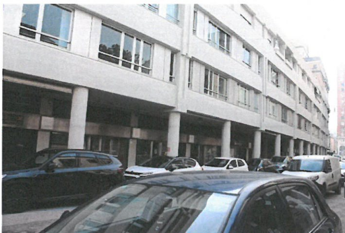
1 – Prospetto del Condominio sulla via Dei Borromeo
