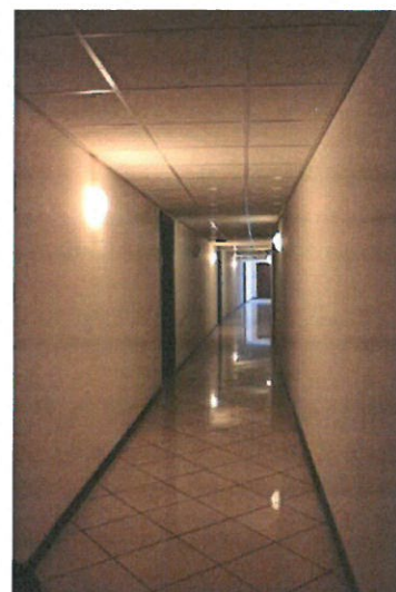
4 – Corridoio di accesso all'ufficio
