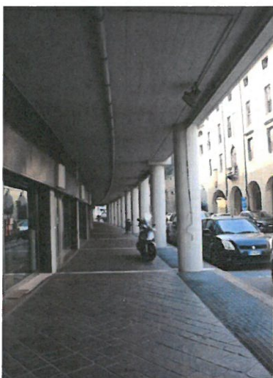
3 – Portico del condominio su via Borromeo
