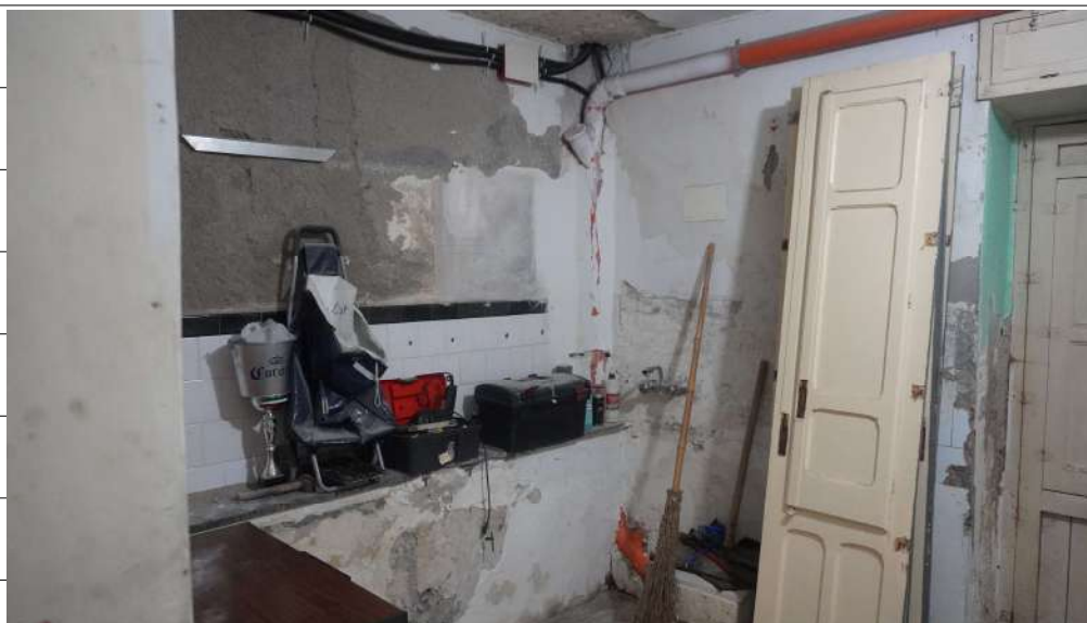
Foto n.4: immagine della stanza ubicata al piano interrato dell'abitazione oggetto di pignoramento.
