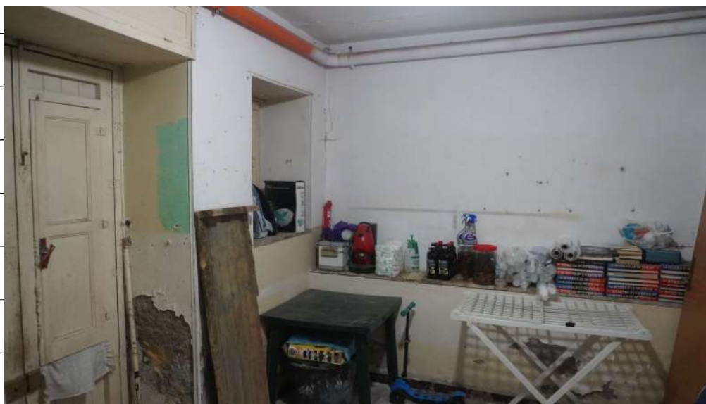
Foto n.5: immagine della stanza ubicata al piano interrato dell'abitazione oggetto di pignoramento.
