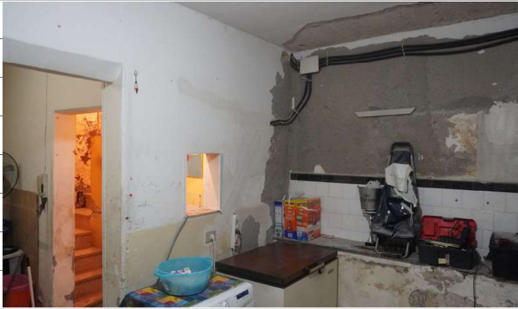
Foto n.6: immagine della stanza ubicata al piano interrato dell'abitazione oggetto di pignoramento.
