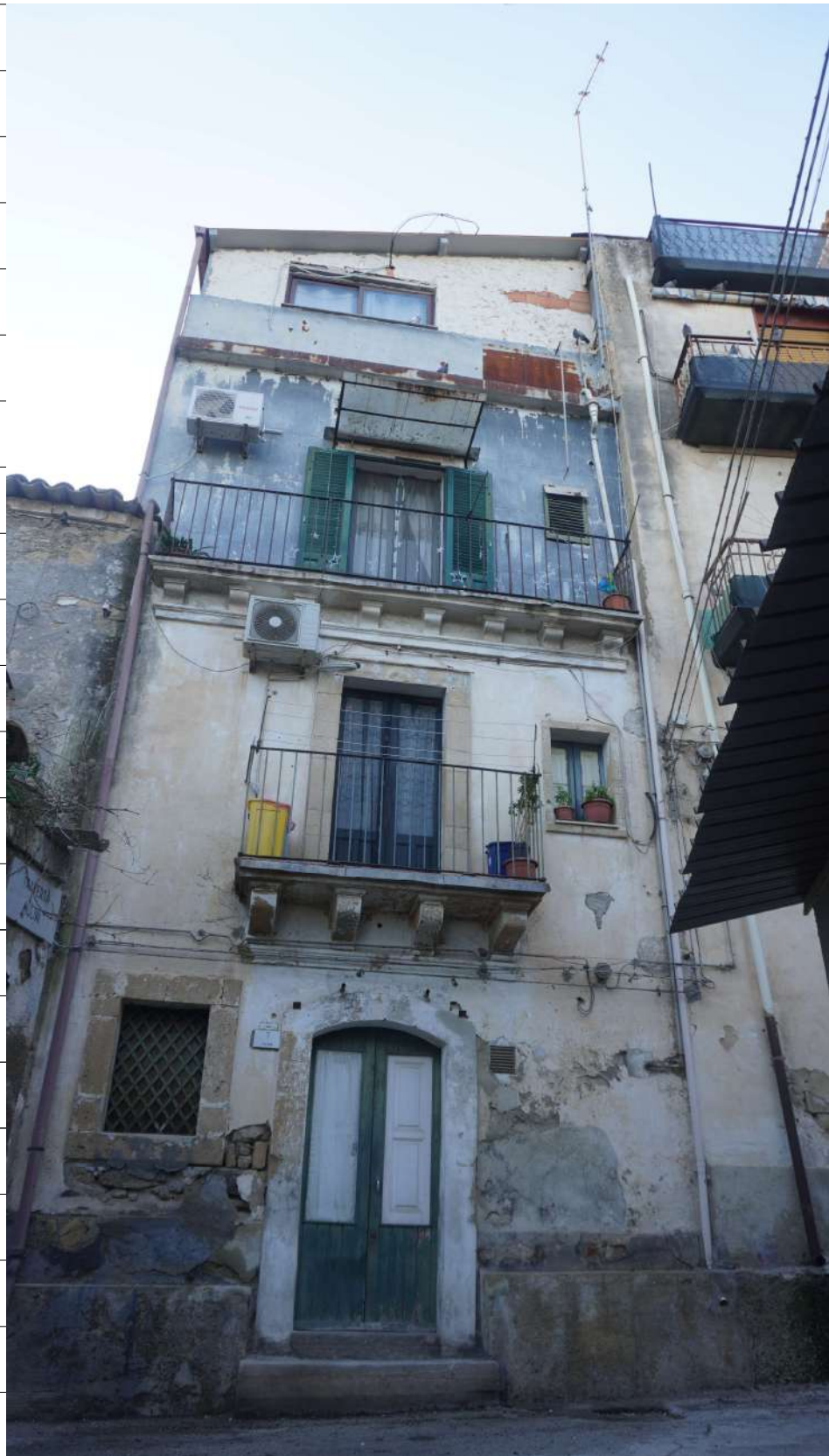
Foto n.3: immagine dell'abitazione, oggetto di pignoramento, con ingresso da via Spagna n.7 a Francofonte.
