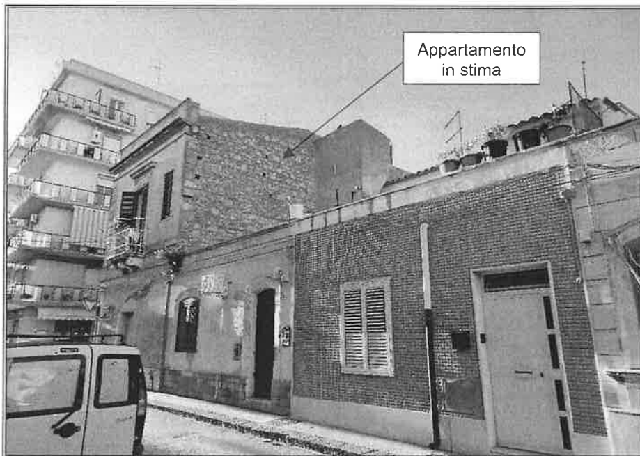
Foto n° 3 – prospetto sul retro prospiciente via Enna
