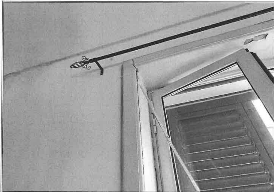
14 - Lesione porta finestra e infiltrazione d'acqua camera 1
