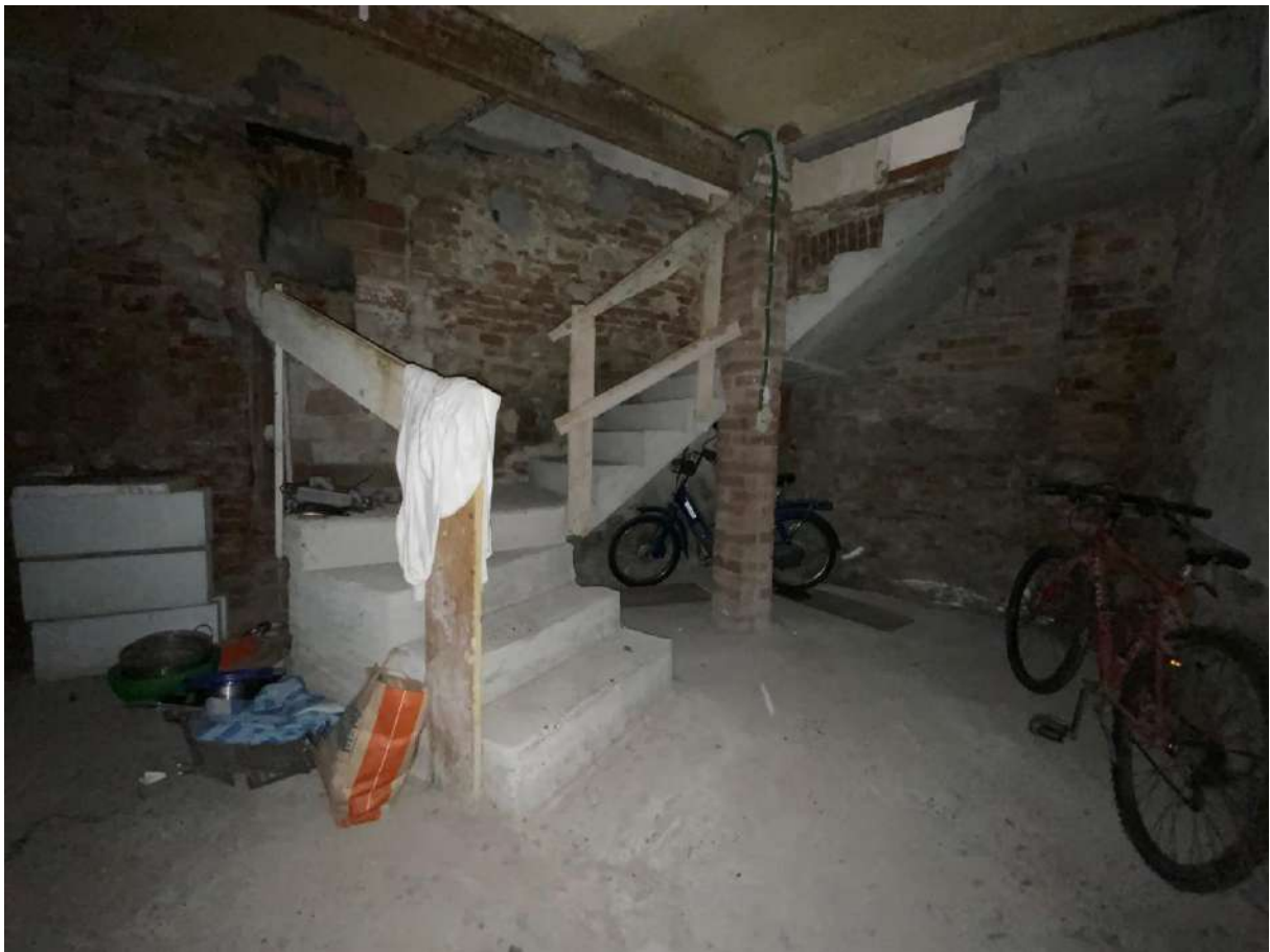
PIANO SEMINTERRATO VANO SCALA
