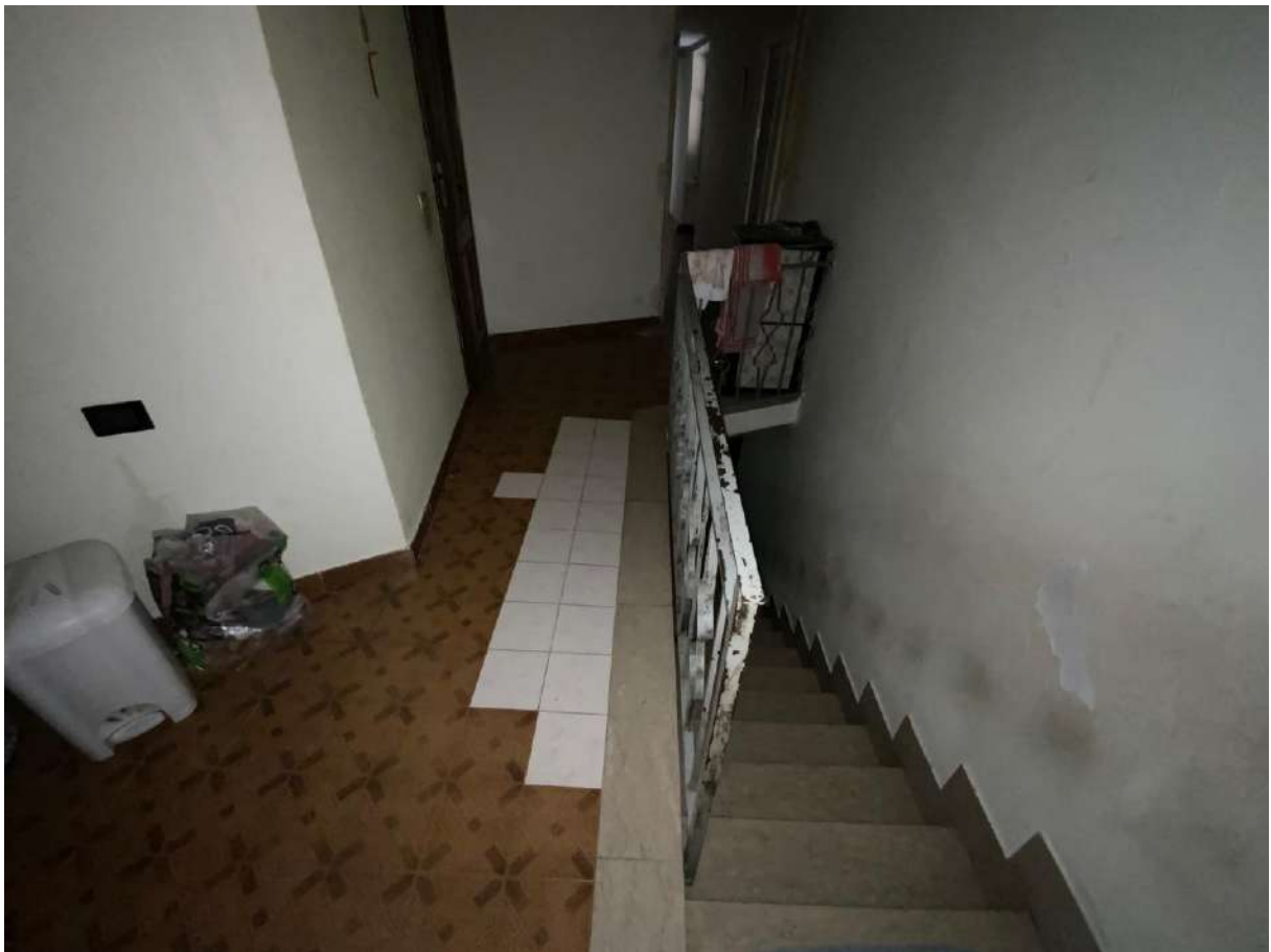
VANO SCALA AL PIANO PRIMO
