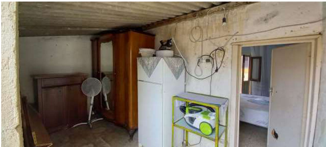
Foto 13 – Immobile “1A” – Tettoia a I P
