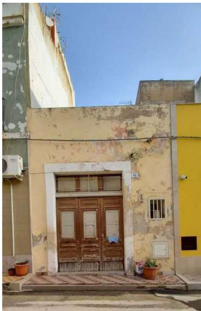
Foto 3 – Immobile “1A” – Prospetto di via De Amicis
