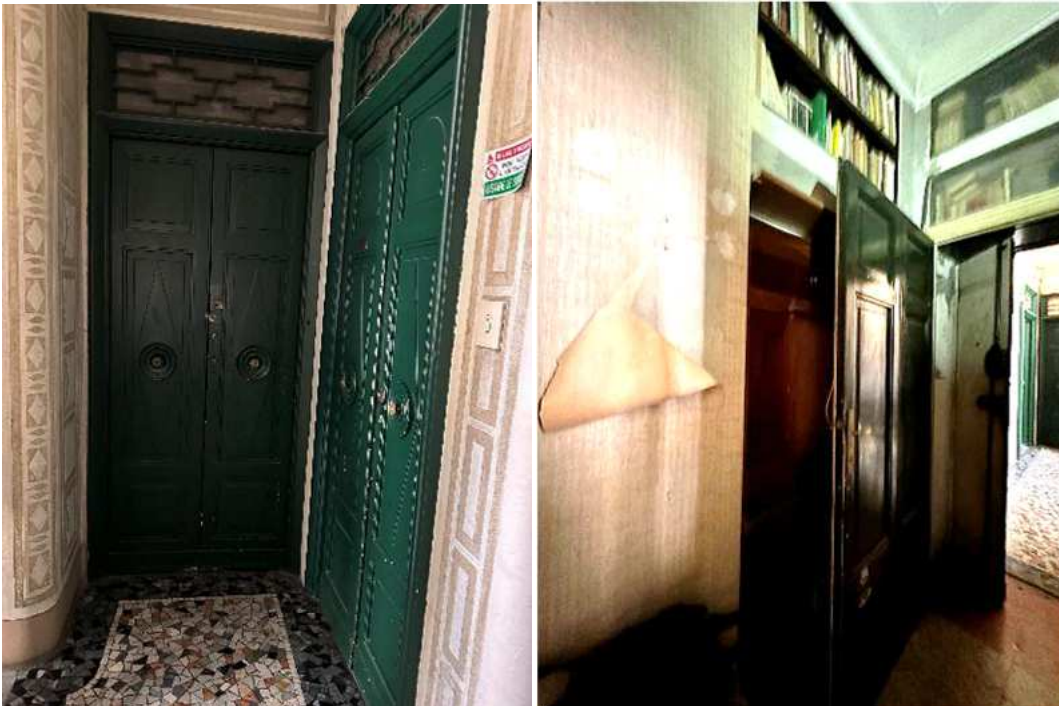
6. Vista della porta di accesso all'alloggio: dal pianerottolo e dall'interno (doppia porta).
