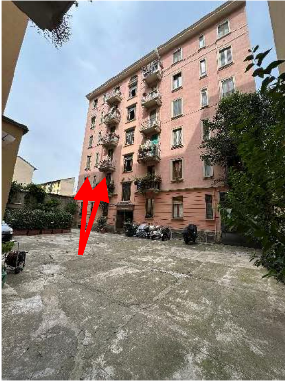
3. Vista del fabbricato interno ed indicazione degli affacci dell'alloggio.
