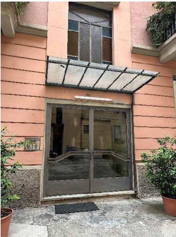
4. Dettaglio del portone di accesso.
