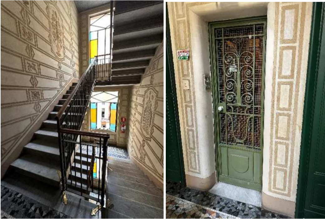
5. Dettaglio delle scale e dell'ascensore condominiali.
