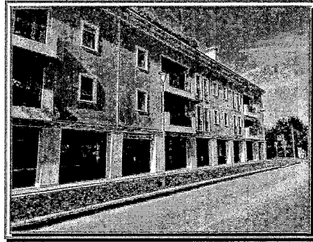
VIA A. DE GASPERI n.21 Condominio "La Piazzetta 3"
