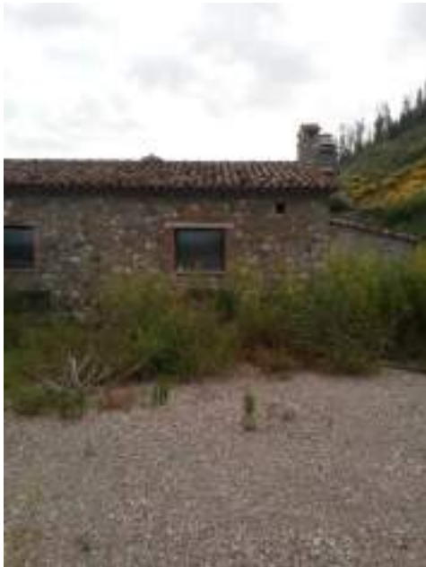
Foto n. 8 – Fabbricato, lato est
