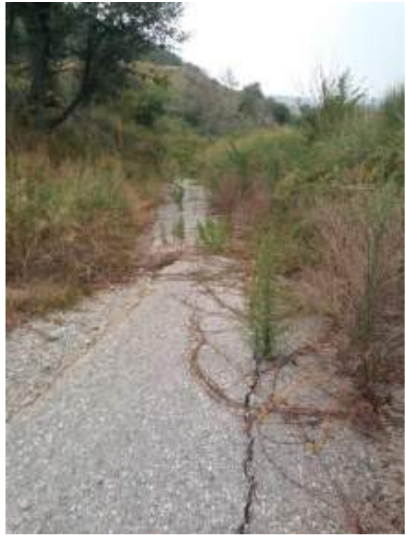
Foto n. 7 – La strada dopo il cancello
