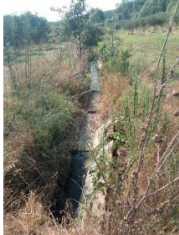
Foto n. 14 – Canale di scolo
