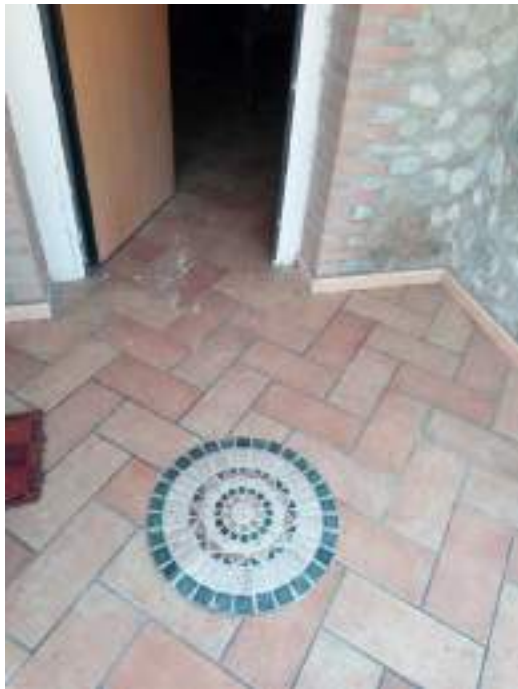
Foto n. 19 – Ingresso al p. terra
