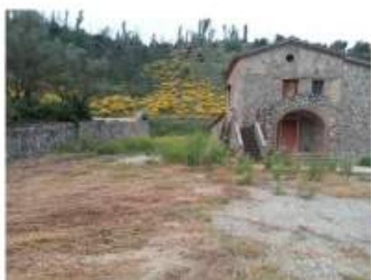
Foto n. 3 – Corte da sud
