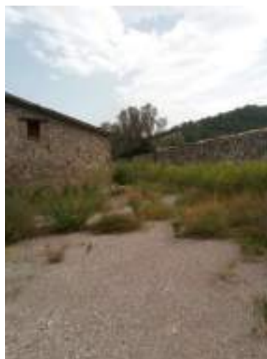
Foto n. 10 – Fabbricato, lato nord-ovest
