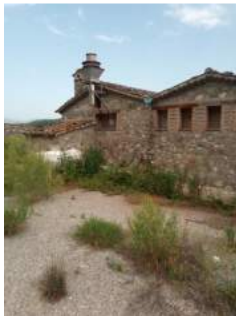
Foto n. 9 – Fabbricato, lato nord
