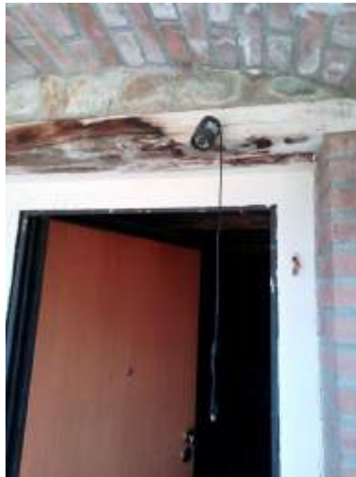
Foto n. 20 – Ingresso al p. terra
