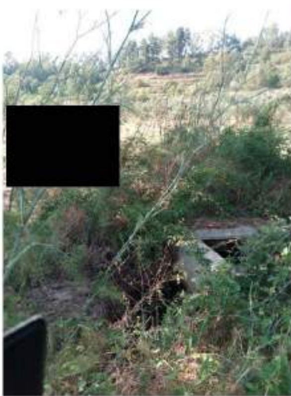
Foto n. 17 – Canale di scolo, nella zona d'accesso
