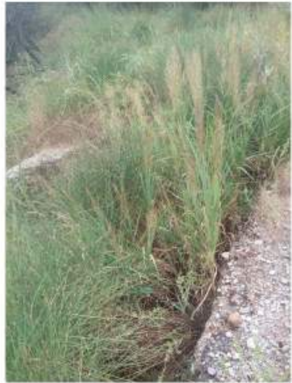
Foto n. 15 – La via impercorribile, particolare
