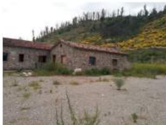
Foto n. 6 – Fabbricato, lato est
