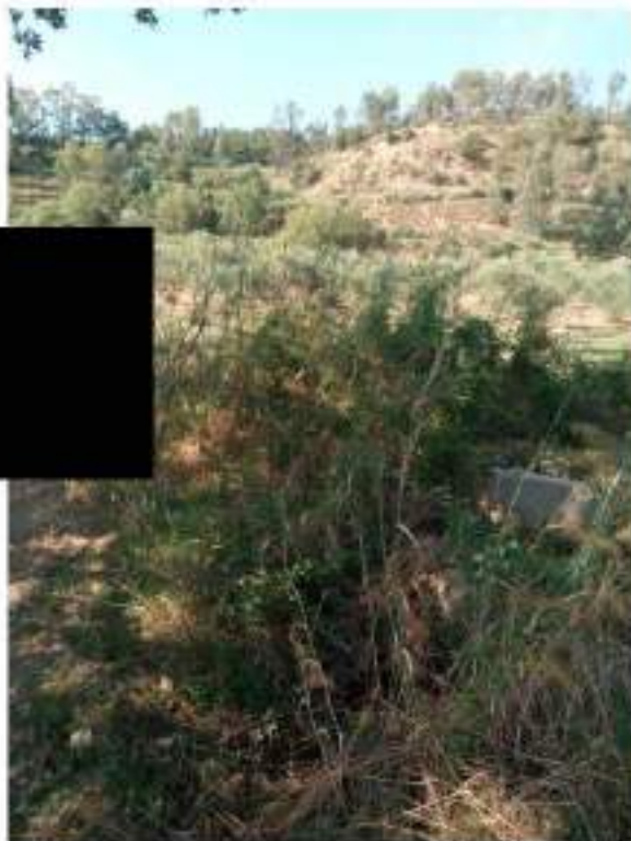
Foto n. 15 – Canale di scolo, nella zona d'accesso
