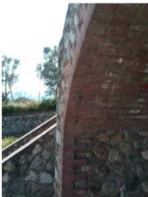
Foto n. 17 – Ingresso al p. terra, verso ovest
