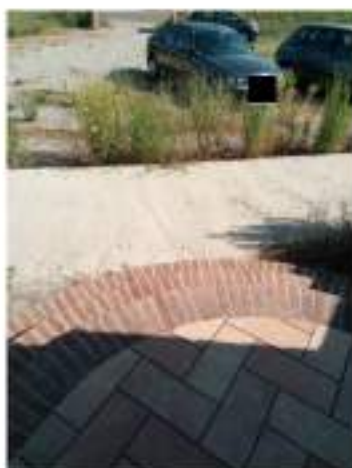
Foto n. 16 – Gradini d'accesso al p. terra
