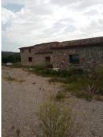
Foto n. 7 – Fabbricato, lato est
