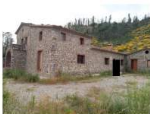
Foto n. 5 – Fabbricato, lato est
