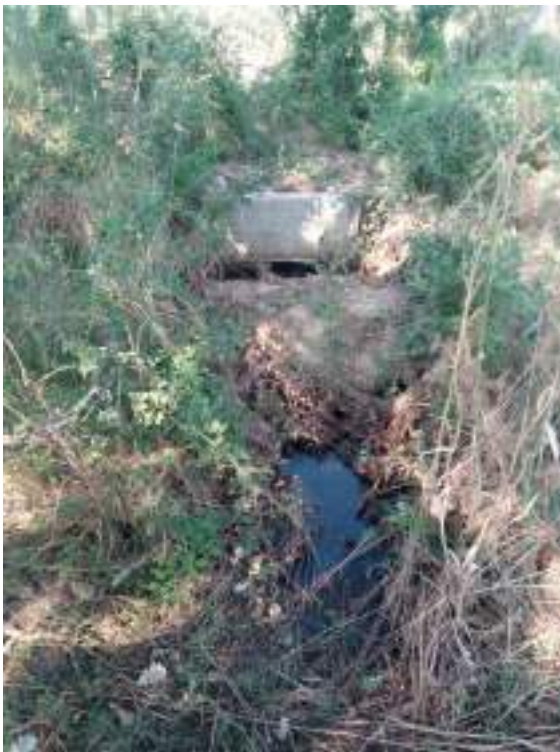
Foto n. 13 – Canale di scolo
