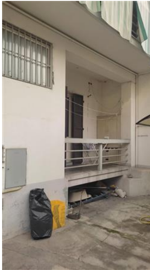
Balcone dell'unità oggetto di pignoramento
