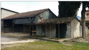
Foto n. 10 - BENE PG.38 PART. 712 Foto Tenzola esterna ;
