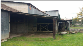
Foto n. 12- BENE FG.38 PART. 712 Foto Tettoia adiacente lateralmente il locale Deposito;
