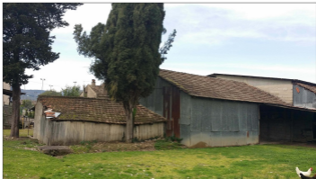
Foto n. 13- BENE FG.38 PART. 712 Foto Tettoia adiacente antistante il locale Deposito e locale annesso;
